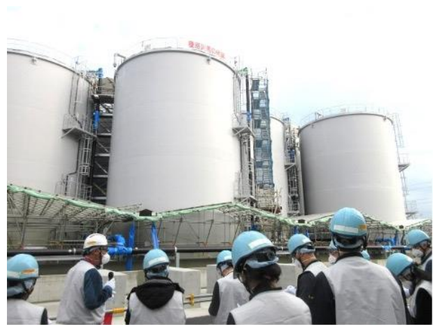
圖 13、分析確認桶槽區(K4 桶槽區)
