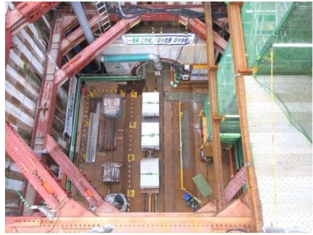
圖 15、海底隧道工地入口
