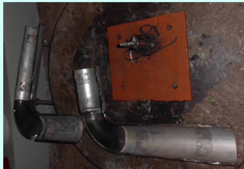
以3 " 套管包覆保護管路
