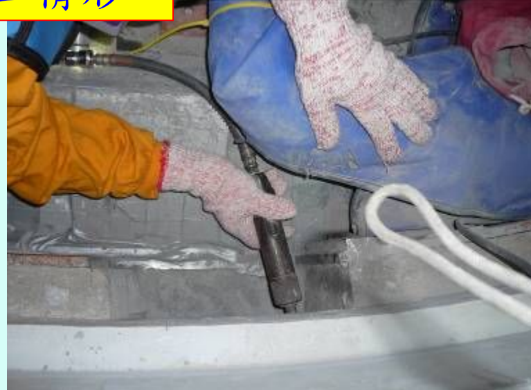
A2螺栓施 工情形
