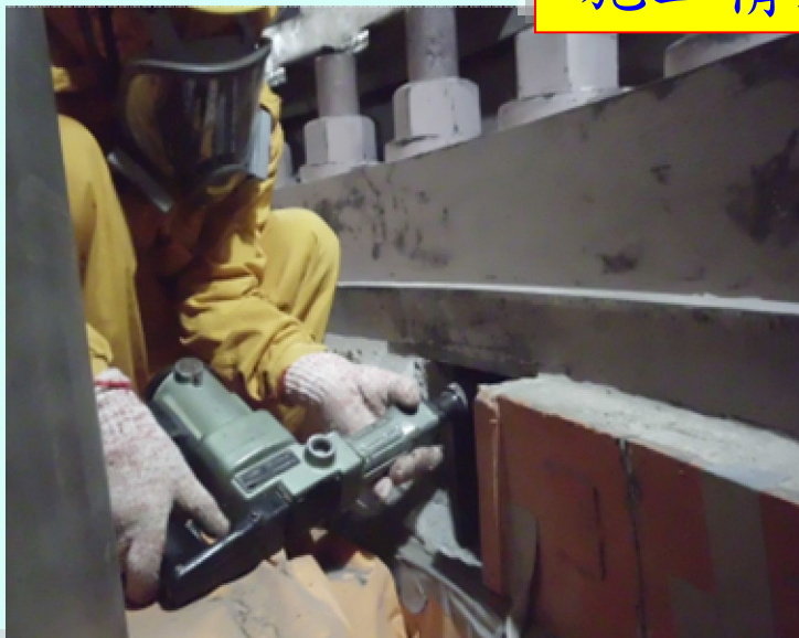
其他螺栓 施工情形
