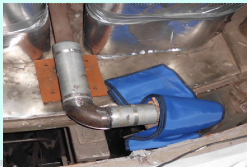
以3 " 套管包覆保護管路
