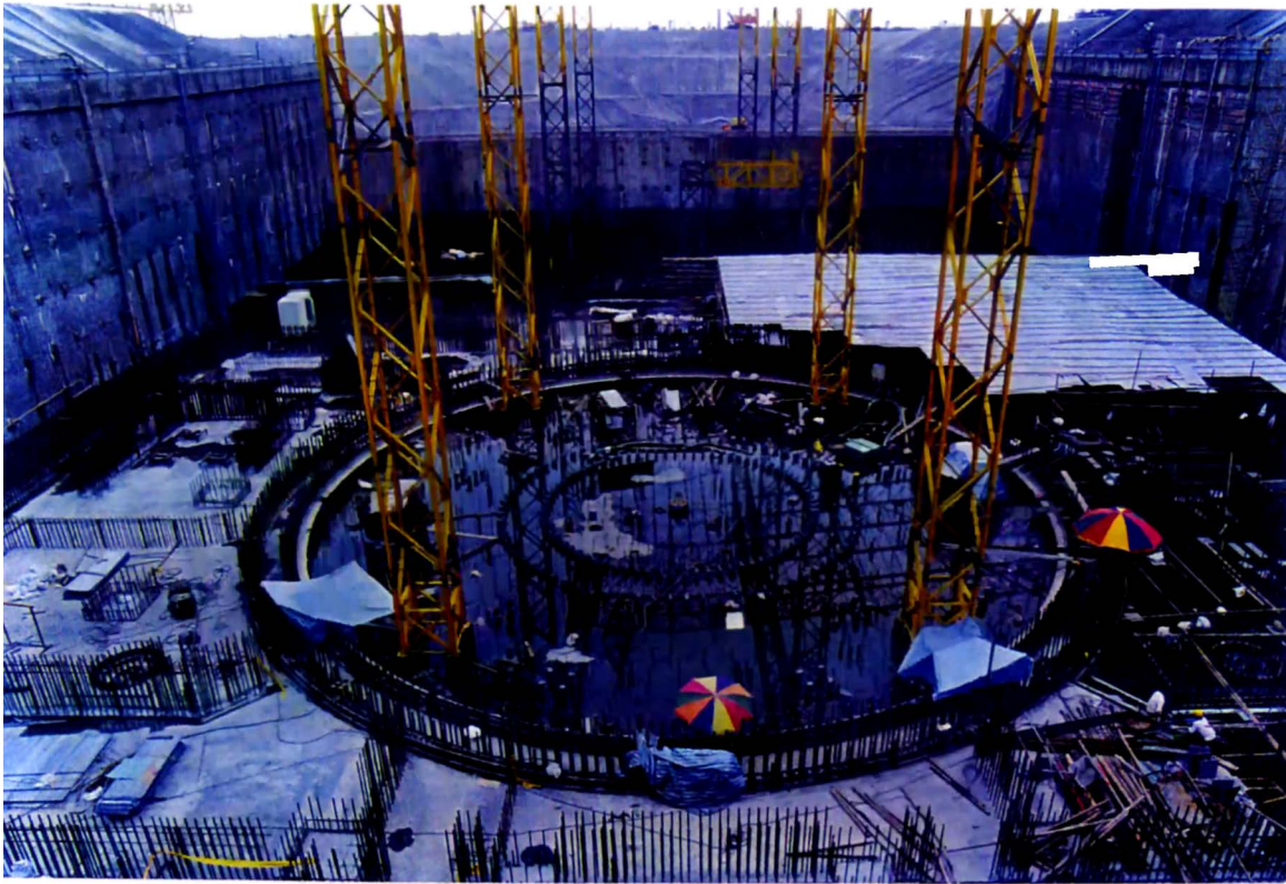
圖一：一號機反應器廠房現況
