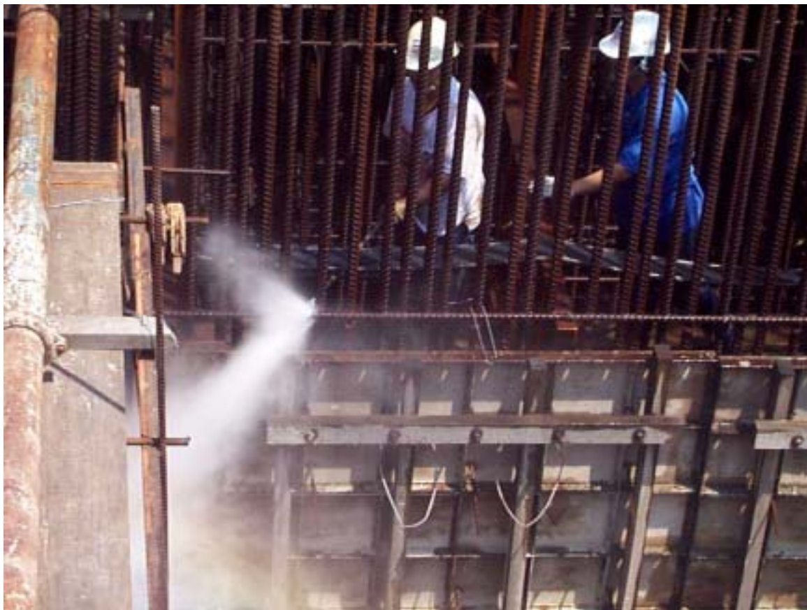
(圖十二) 一號機汽機廠房基礎第三區塊之水刀除鏽情形
