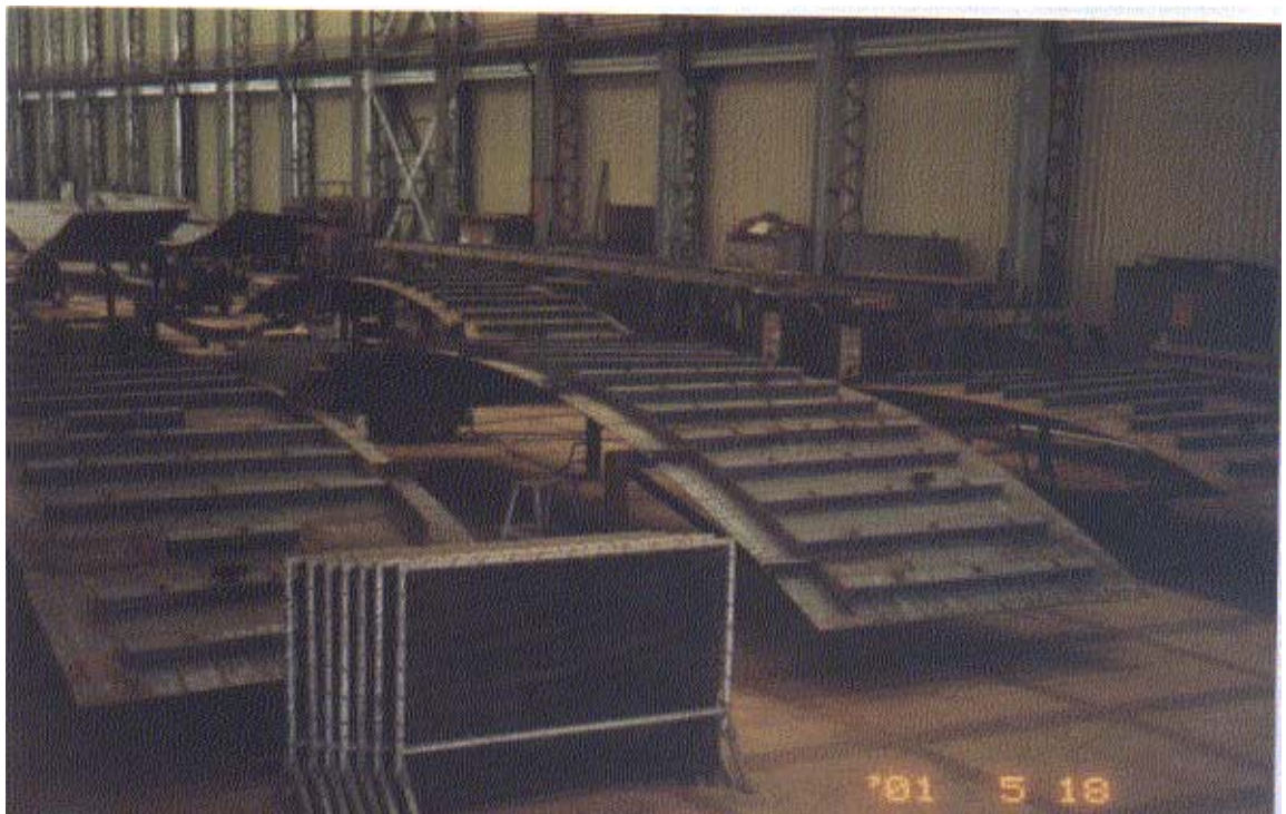
(圖二十四) 赴中船公司視察圍阻體襯板施工現場排放情形
