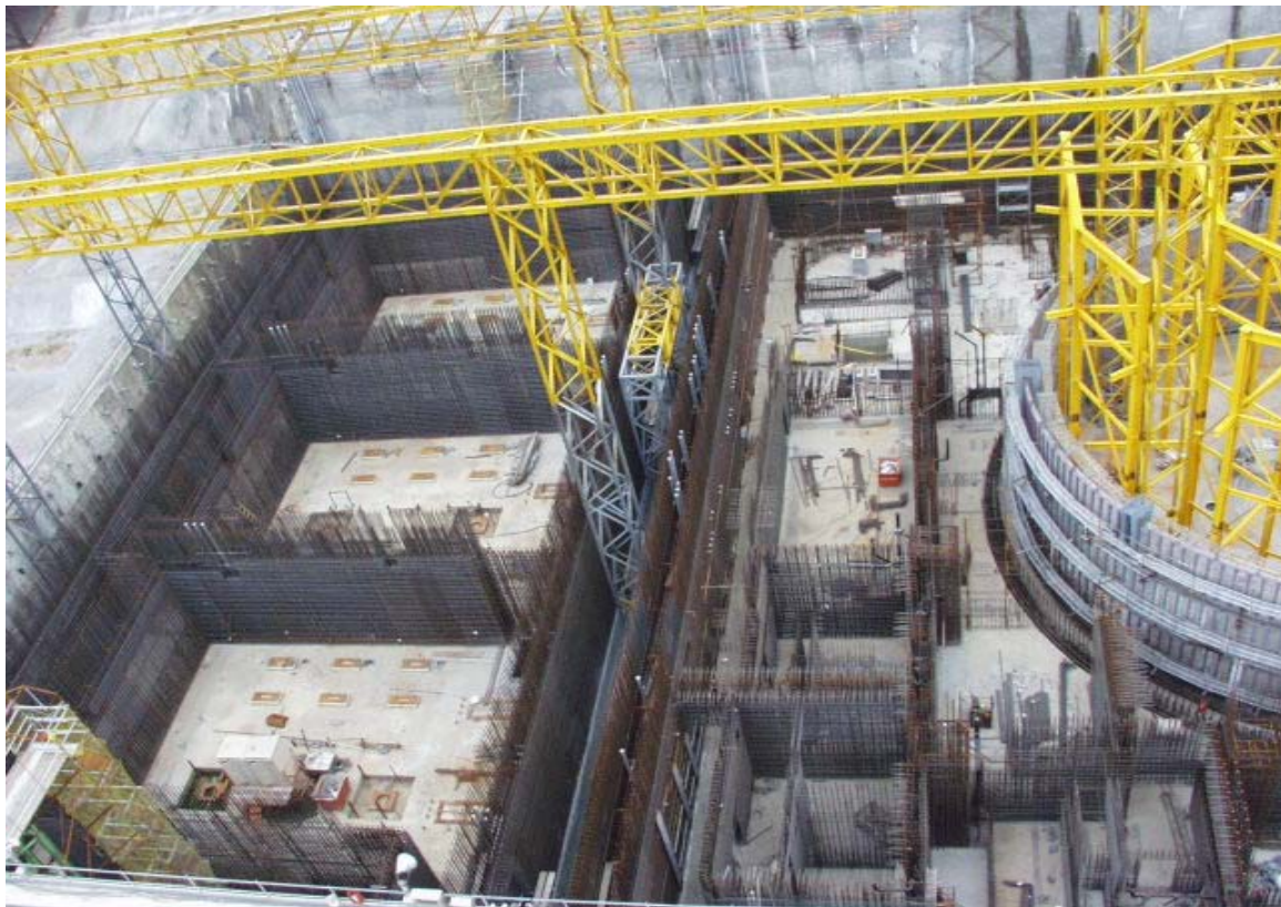
(圖二) 一號機控制室廠房施工現況圖
