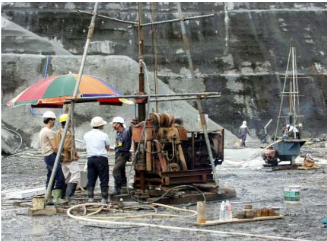
(圖五) 二號機汽機廠房進行鑽探及地球物理探測施工現況圖
