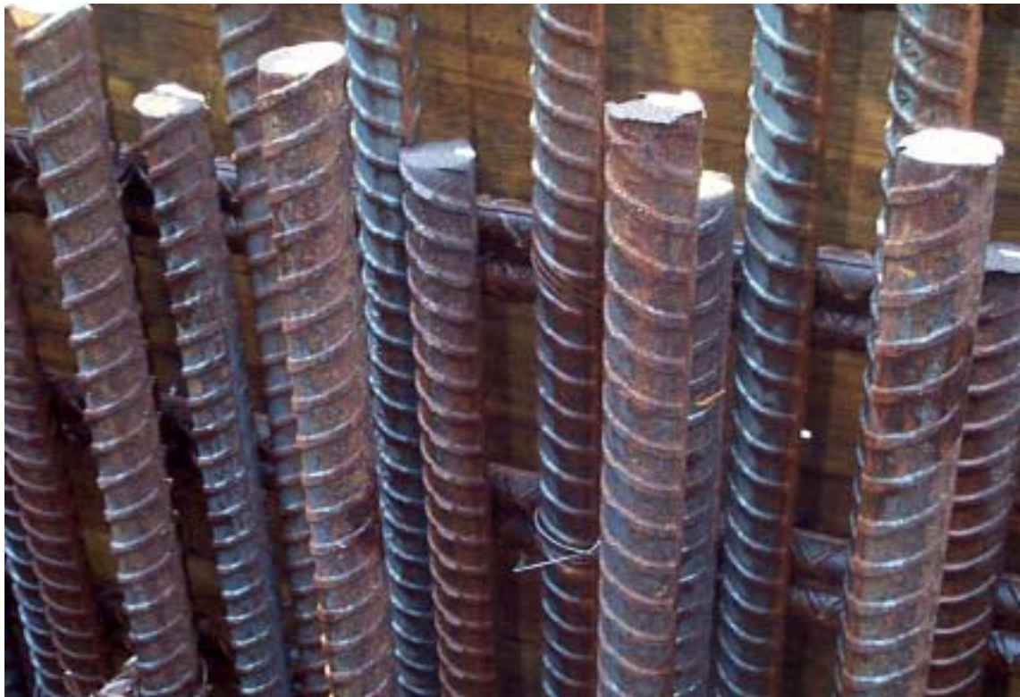
(圖十三)一號機汽機廠房基礎第三區塊之水刀除鏽鏽後情形
