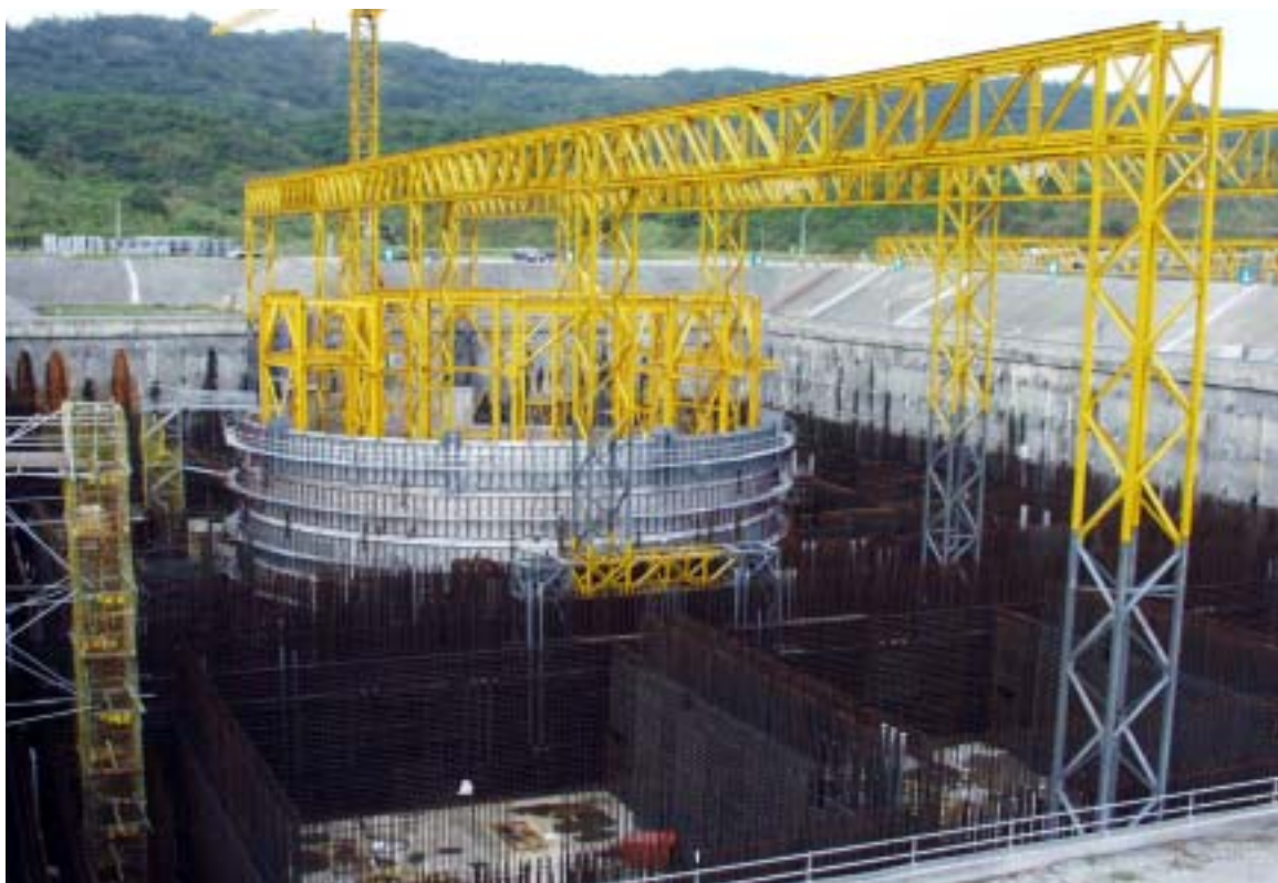
(圖一) 一號機反應器廠房圍阻體襯鉸第四昇層完成施工現況圖
