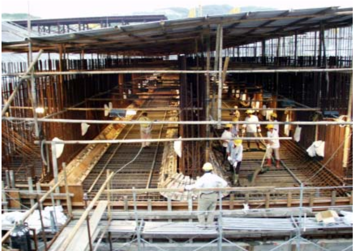
(圖三) 一號汽機廠房基礎版第四區塊施工現況圖
