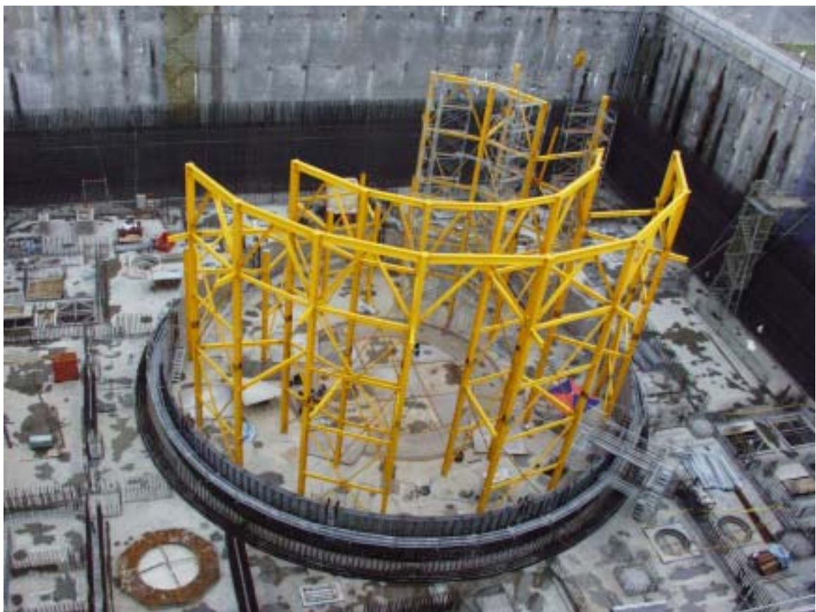
(圖四) 二號機反應器廠房圍阻體襯鈹第一昇層完成施工現況圖
