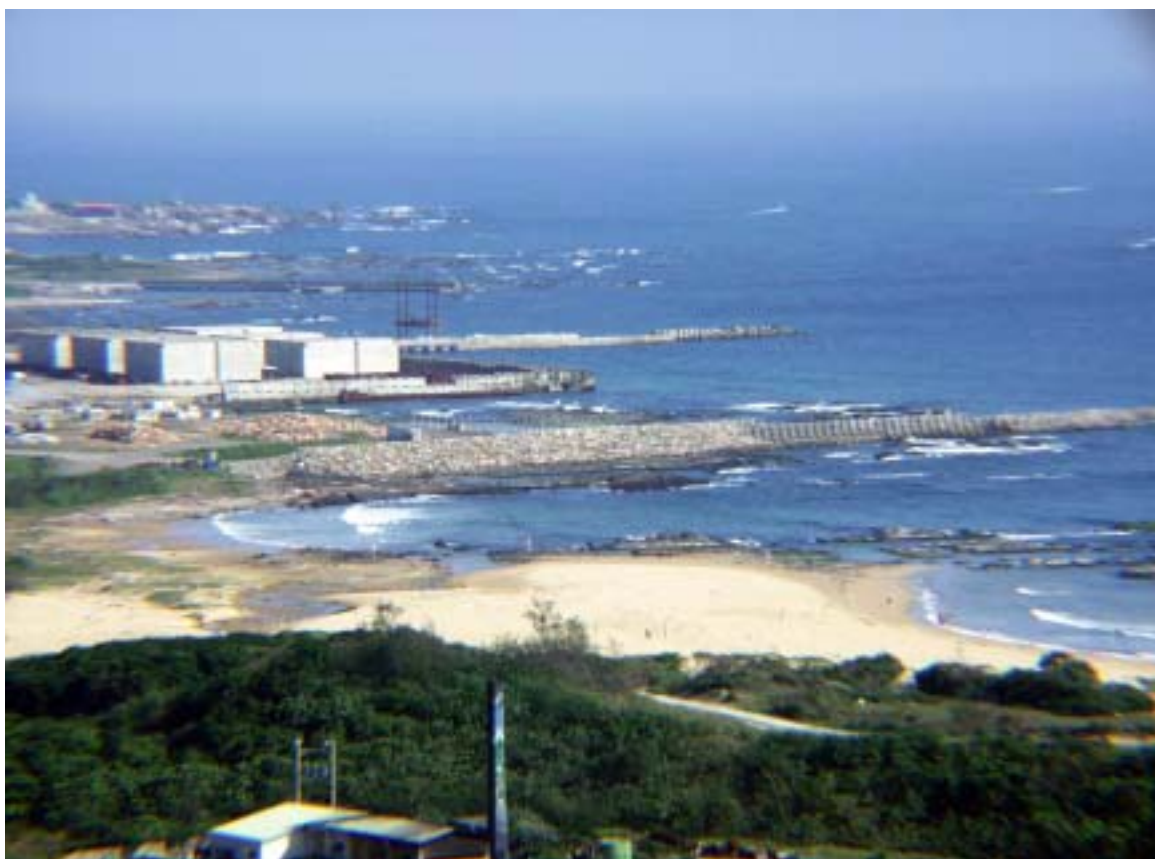
(圖六) 進水口防波堤及重件碼頭施工現況圖
