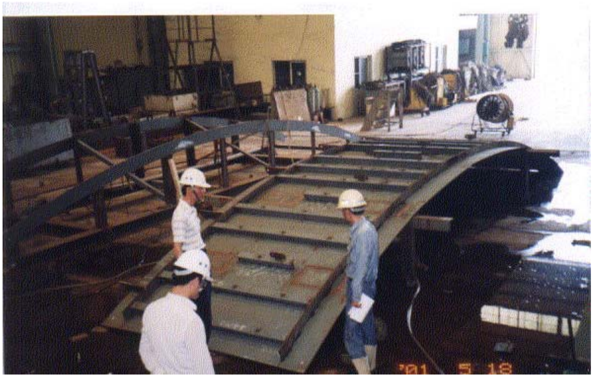
(圖二十三) 赴中船公司視察圍阻體襯板施工現場情形
