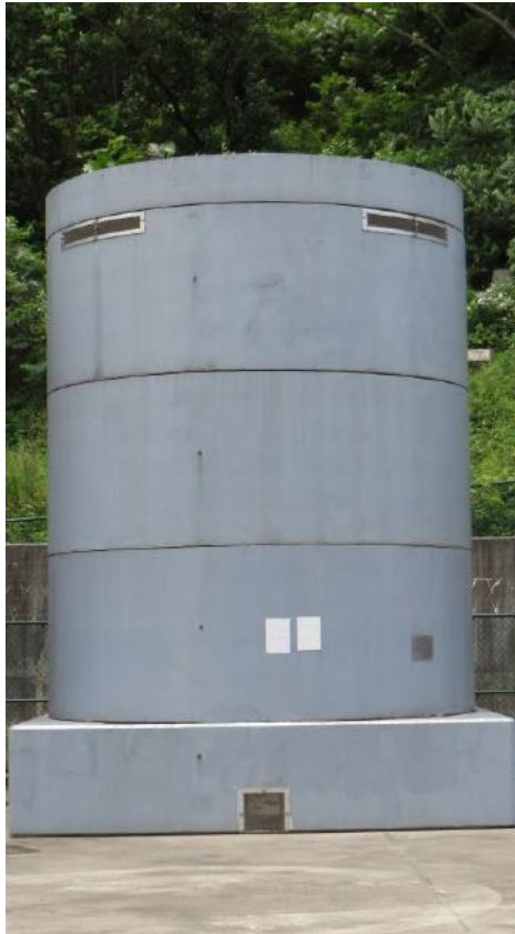
圖 19.5 核一廠 INER-HPS 乾式貯存護箱外觀
