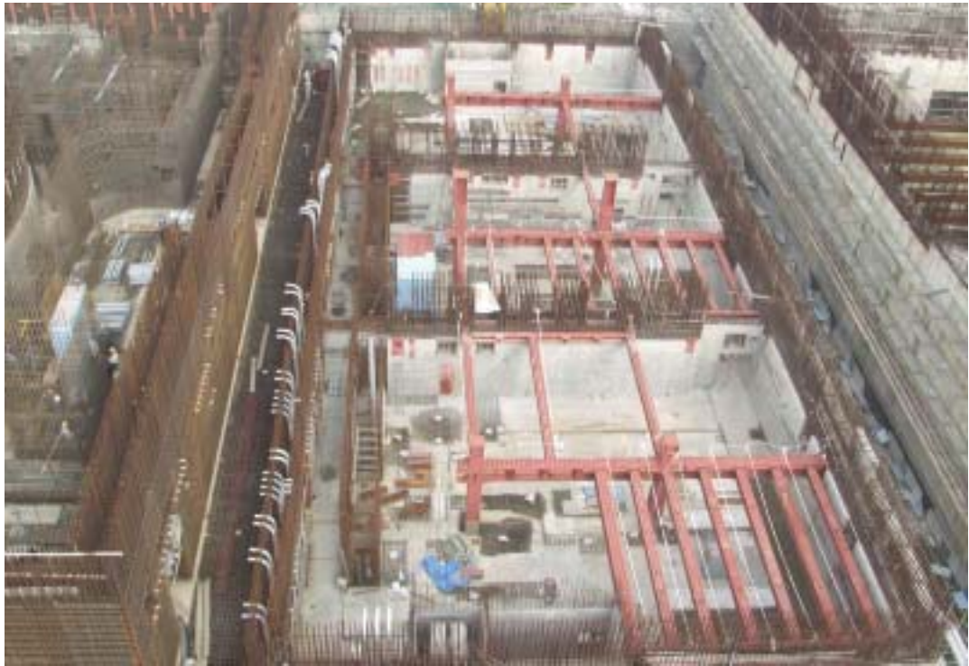
照片三：一號機控制廠房施工現況
