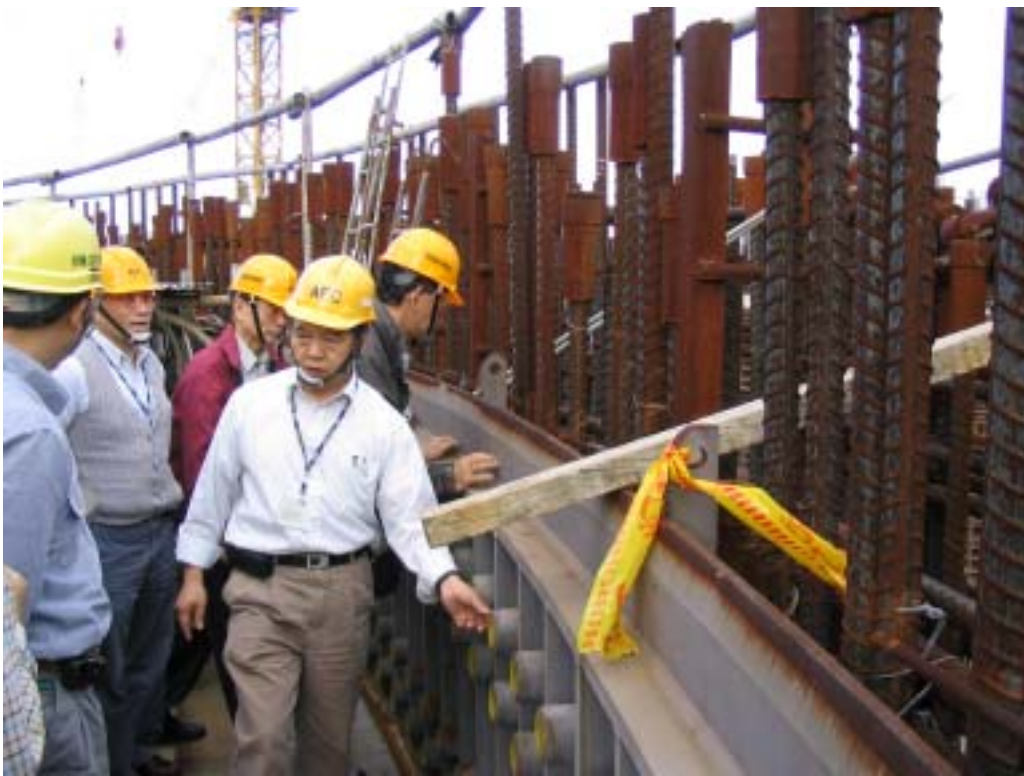
照片十二：視察一號機 RCCV LINER 施工現場情形
