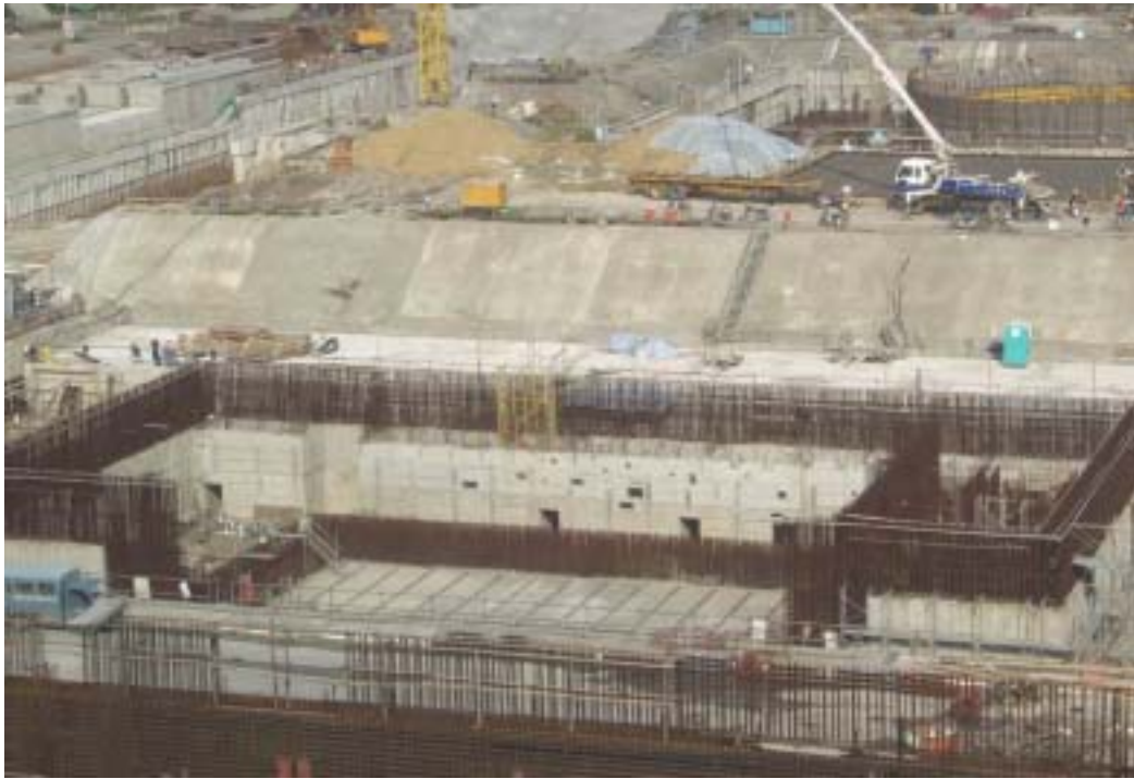
照片五：輔助用過燃料廠房施工現況
