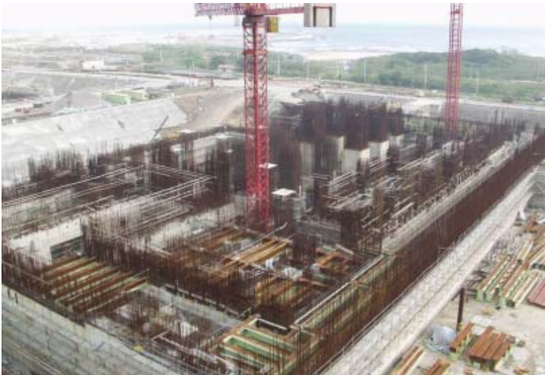
照片四：一號機汽機廠房施工現況
