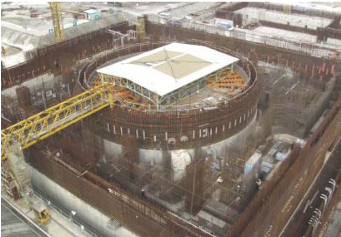
照片二：一號機反應器廠房施工現況
