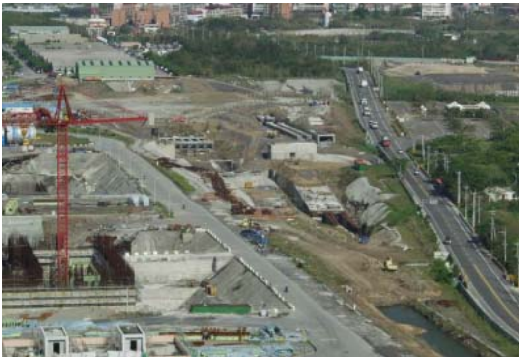
照片六：進水暗渠施工情形
