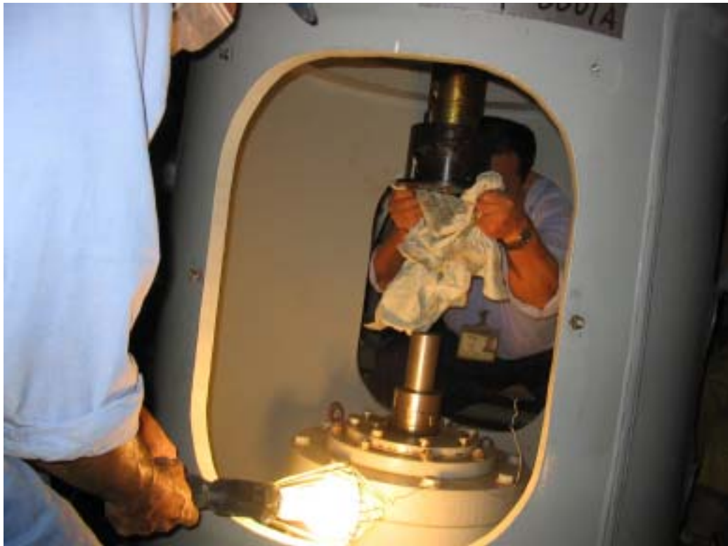
照片十一：視察一號機 RHR Pump 維護保養作業情形(二)
