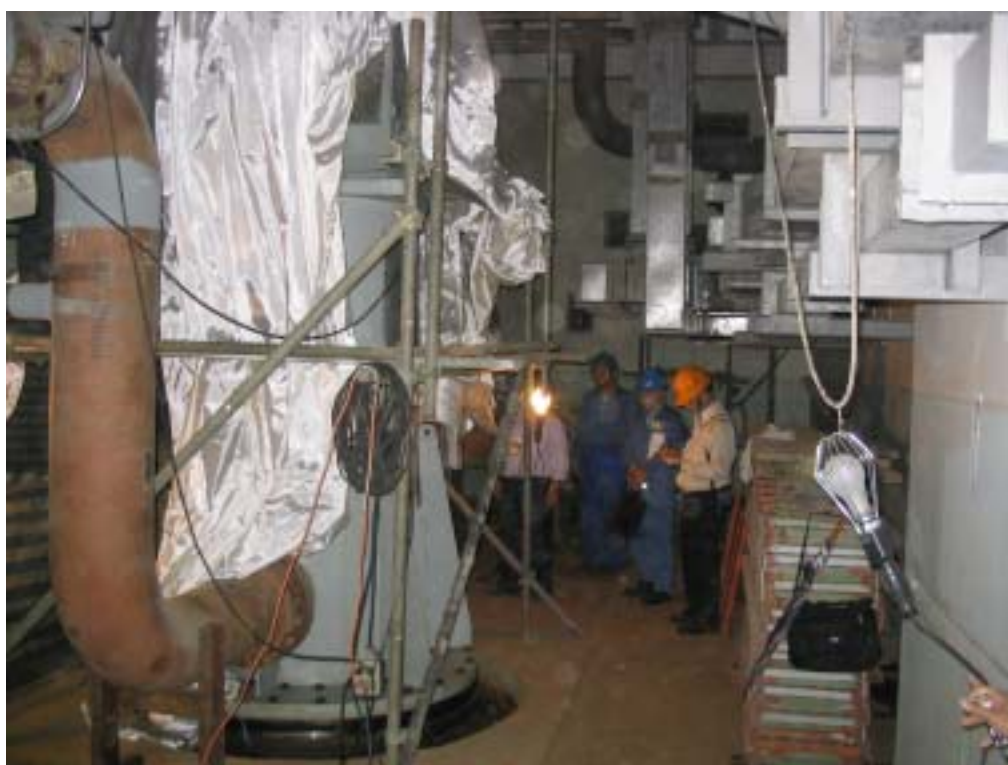
照片十：視察一號機 RHR Pump 維護保養作業情形(一)
