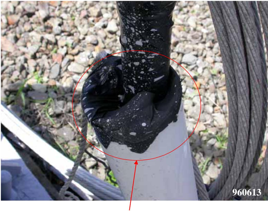
圖三 161KV 開關場 OPGW 套管填充物欠缺
