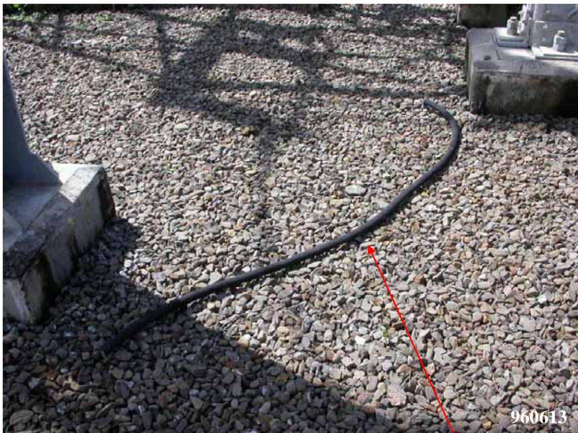
圖一 161KV 開關場地面發現工程完工後遺留異物
