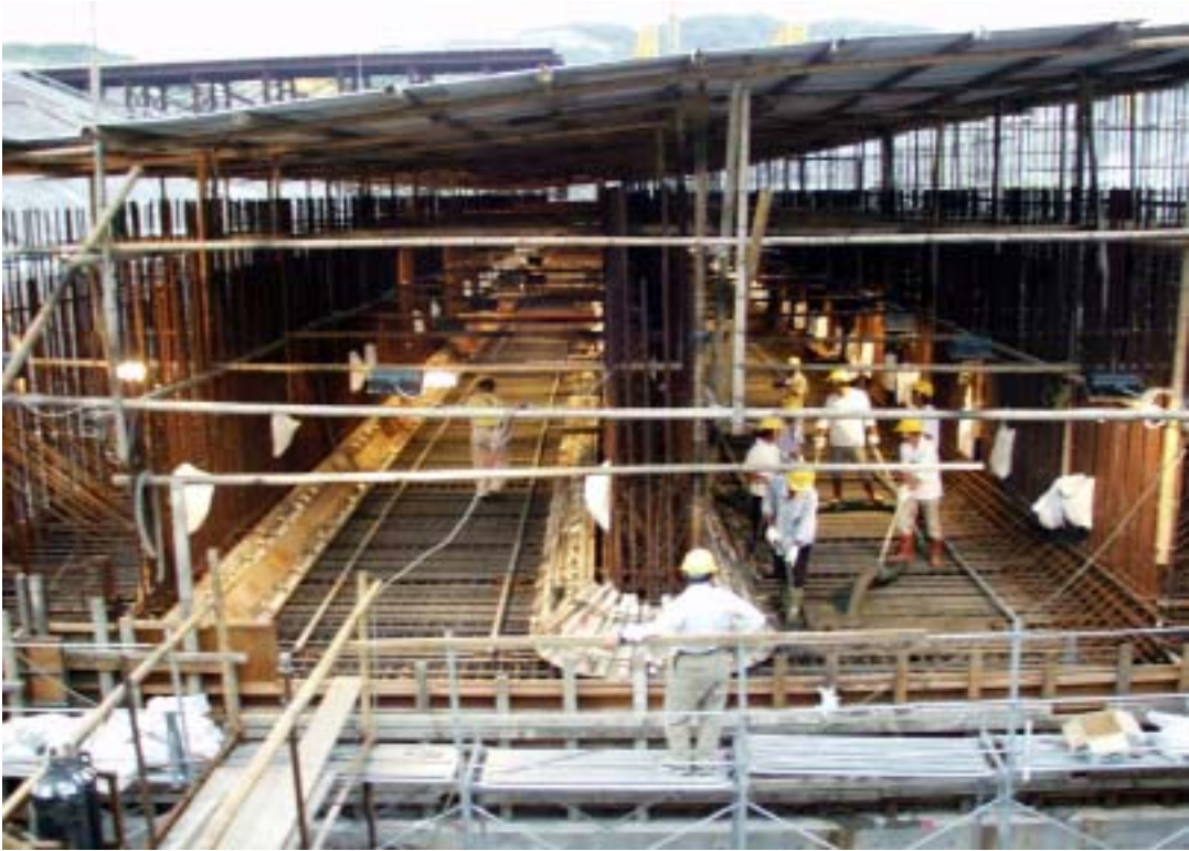
圖三：一號汽機廠房施工現況
