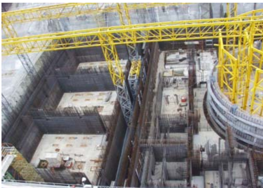
圖二：一號機控制室廠房施工現況
