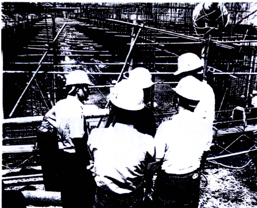
圖十：視察一號機汽機島區工地（補）
