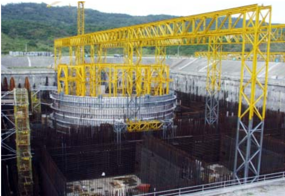
圖一：一號機反應器廠房施工現況
