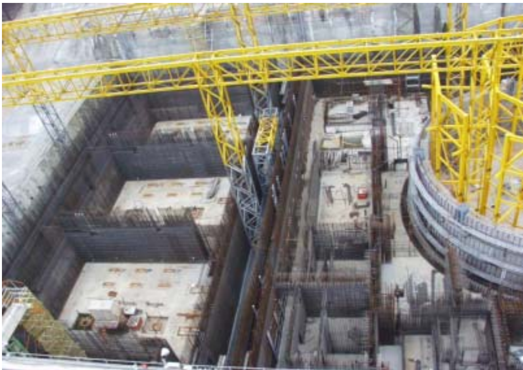
圖二：一號機控制室廠房施工現況圖
