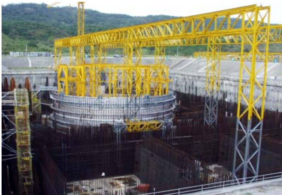
圖一：一號機反應器廠房施工現況圖
