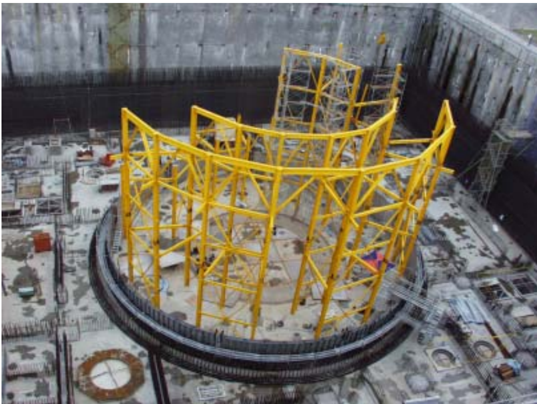
圖四：二號機反應器廠房施工現況
