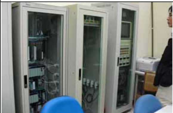
照片 8：PLC-Allen Bradley，Modicon Quantum，GE Fanuc
