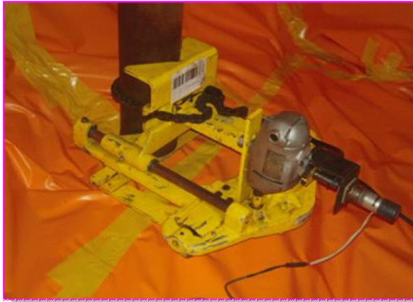
螺樁切除作業
