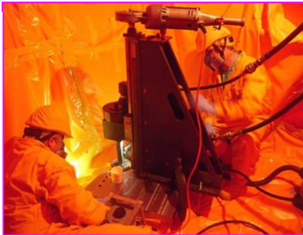
圖 6 螺樁殘根鑽孔
