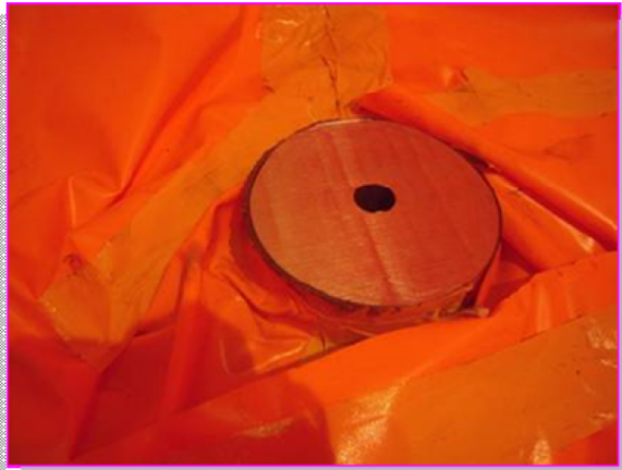
螺樁切除後超音波檢測
