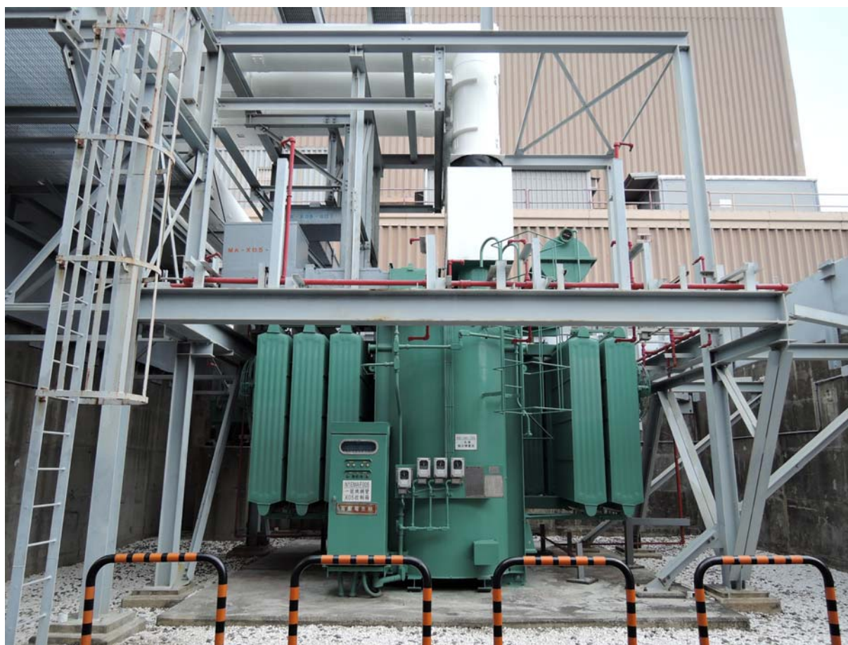
圖三.3 一號機輔助變壓器 MA-X05
