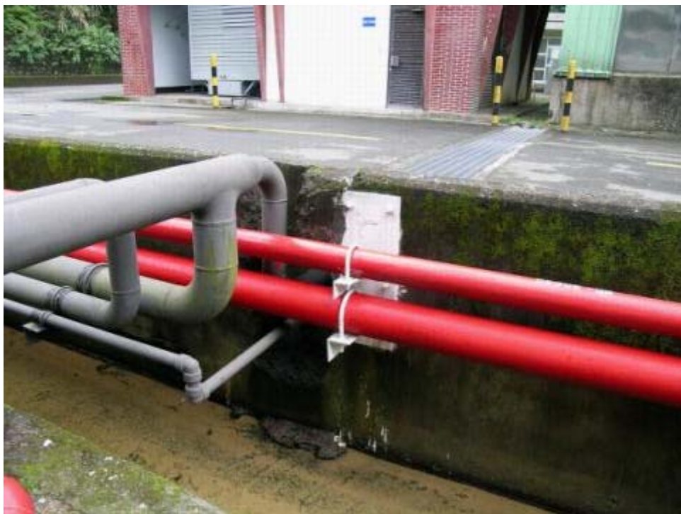
圖七：汽渦輪機廠房外排水溝堰牆之開口
