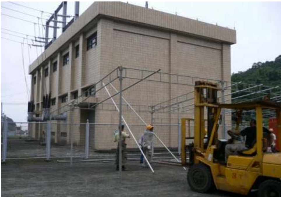
圖二：69KV 開關場旁正進行帆布遮雨棚施工以做為切割鋼管場所
