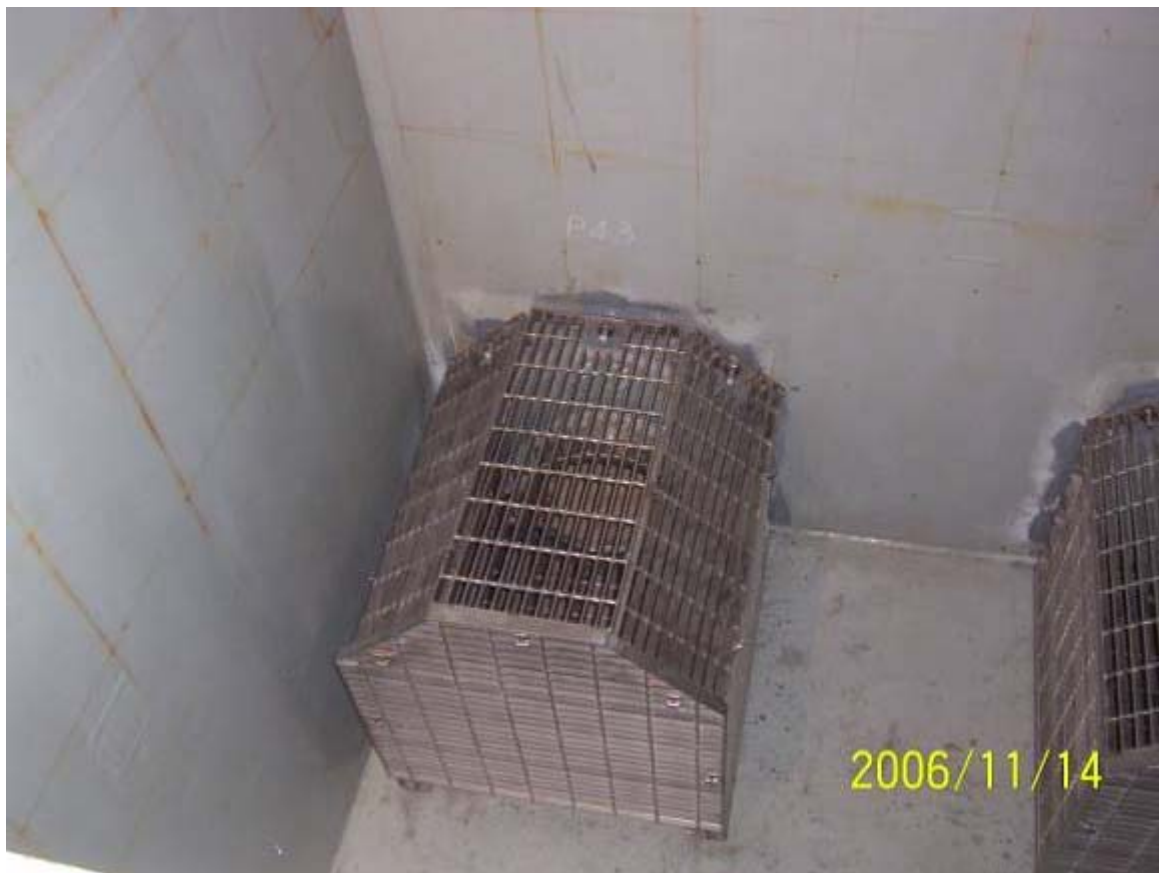
圖九、十 SUMP 內之雜物已全面清除。
