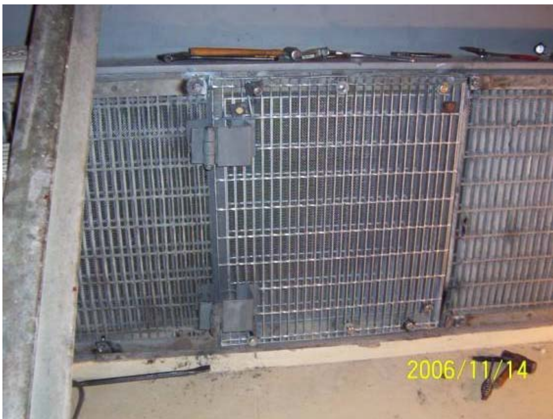
圖四 加裝檢查口蓋
