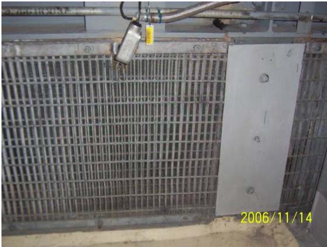
圖三 所有螺栓均確實鎖緊
