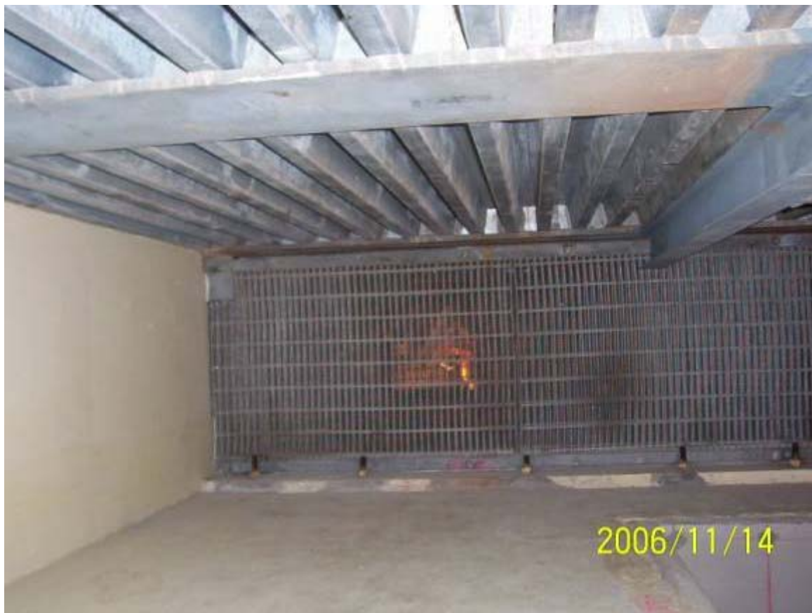
圖七、八 SUMP 內之雜物已全面清除。
