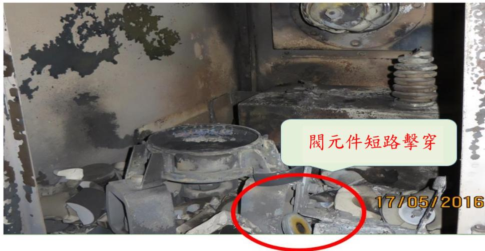
圖 31 C相避雷器內部元件擊穿照片
