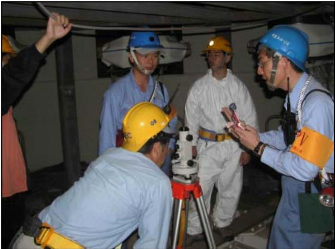
照片五十二 地錨螺栓鎖磅後於爐底中心使用垂直儀測量
