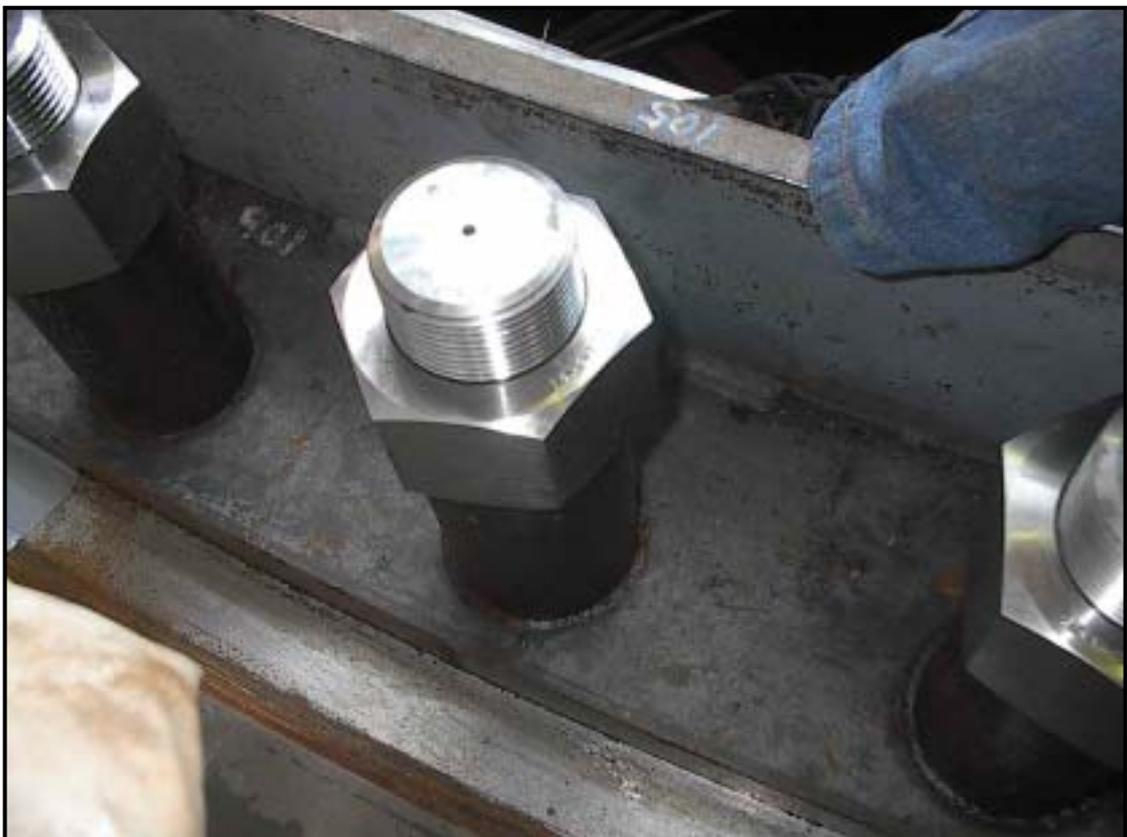
照片五 Anchor Bolt 座落於模鋁孔洞中
