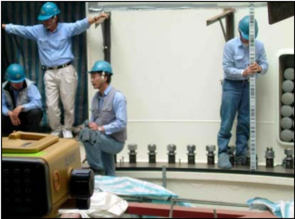
照片十二 安裝後水平測量作業
