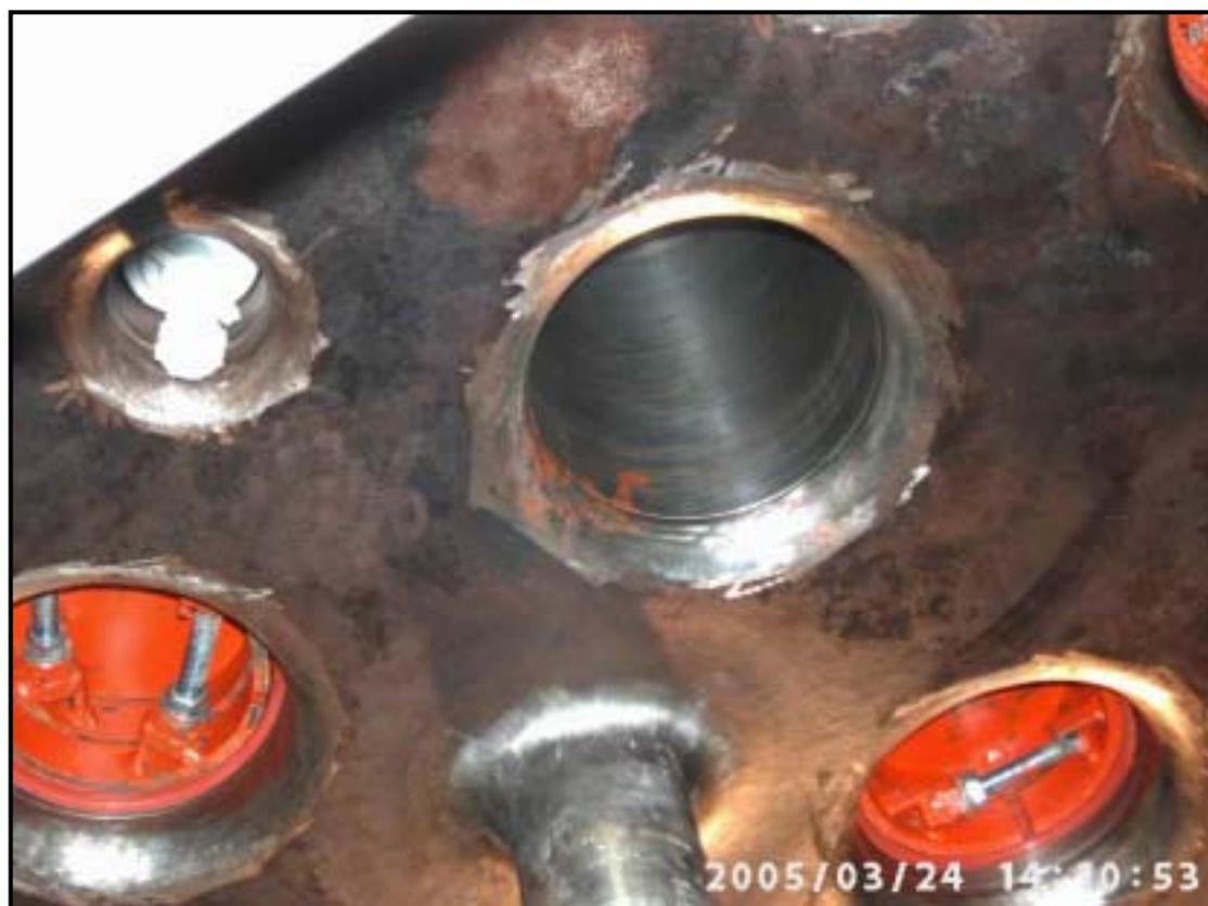
照片五十九 RPV 爐底穿越管以紅色管塞氣密保護內部
