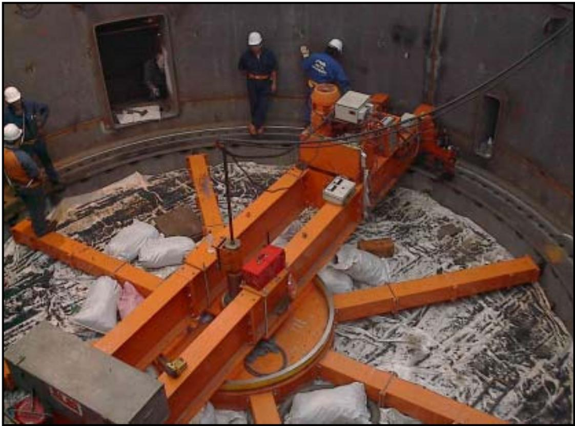
照片四 支撐托架上鋁平面加工
