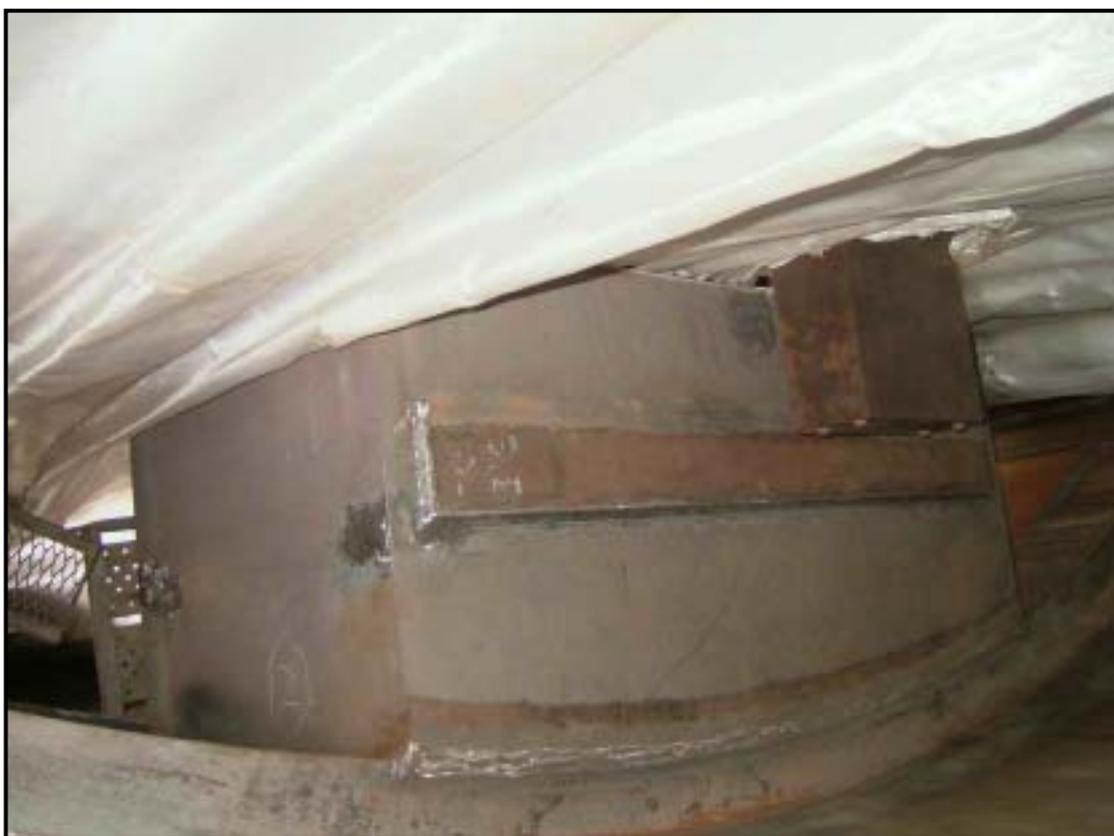
照片五十八 屏蔽牆支撐架銲接完成（穩定器）
