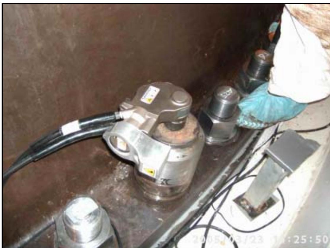
照片五十五 油壓鎖磅機進行最後之對稱鎖磅
