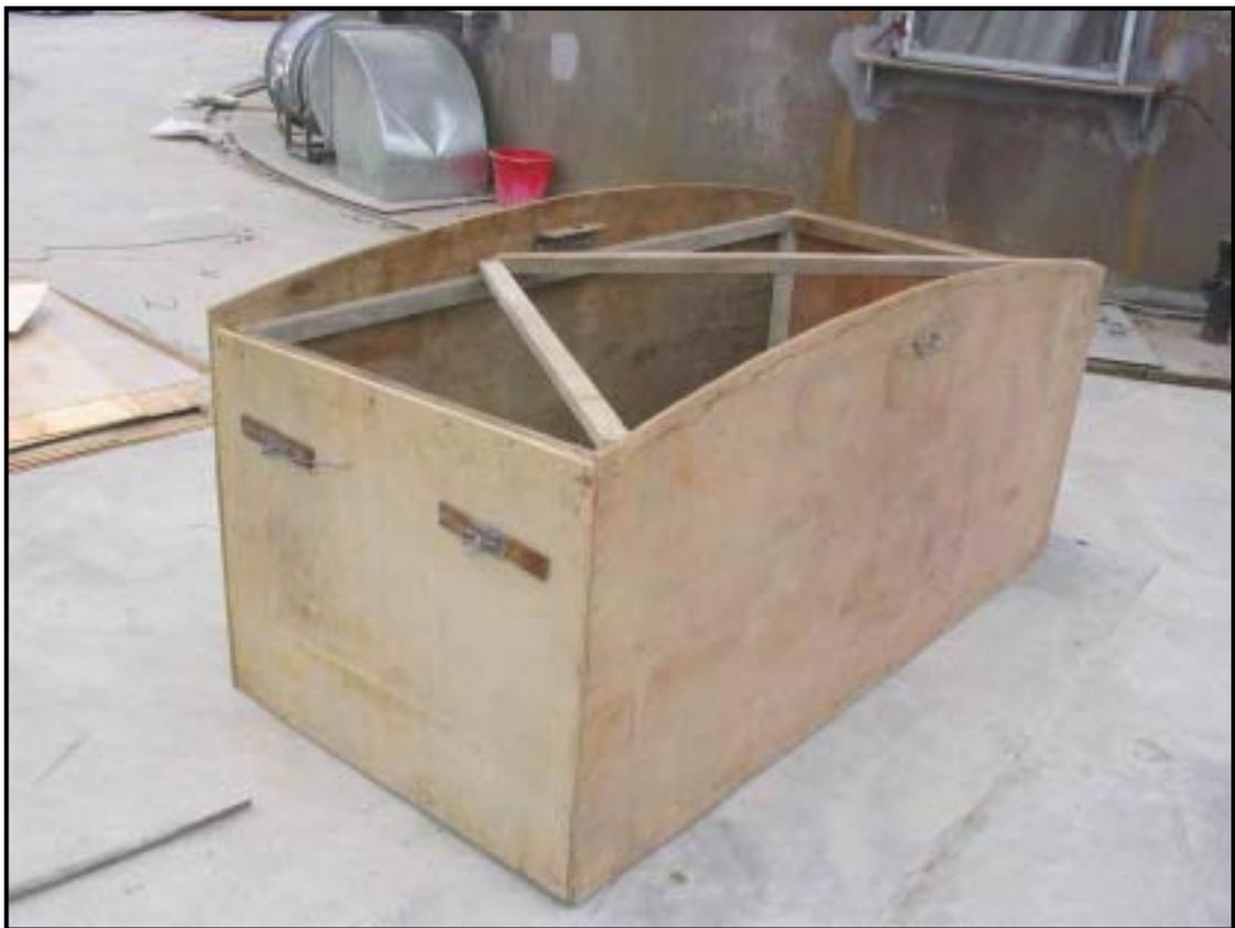
照片五十七 屏蔽牆支撐架實體木模（穩定器）
