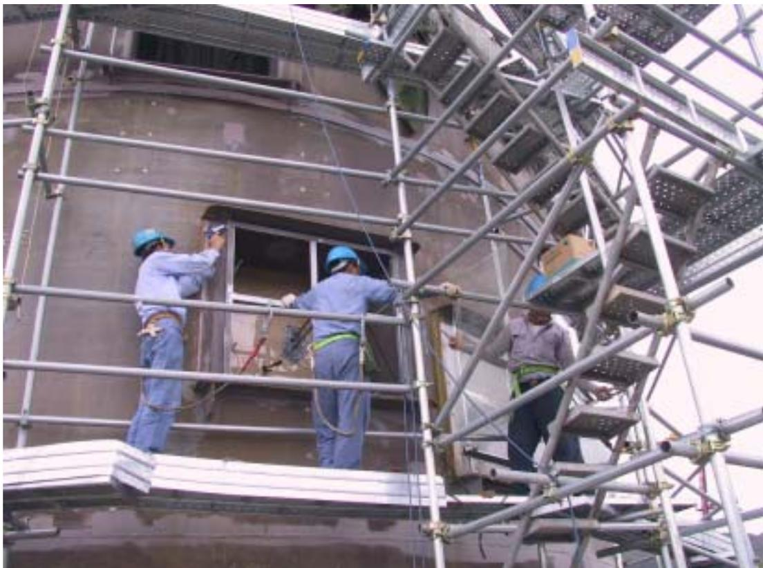
照片六十五 RPV 屏蔽牆穿越孔安裝遮雨窗
