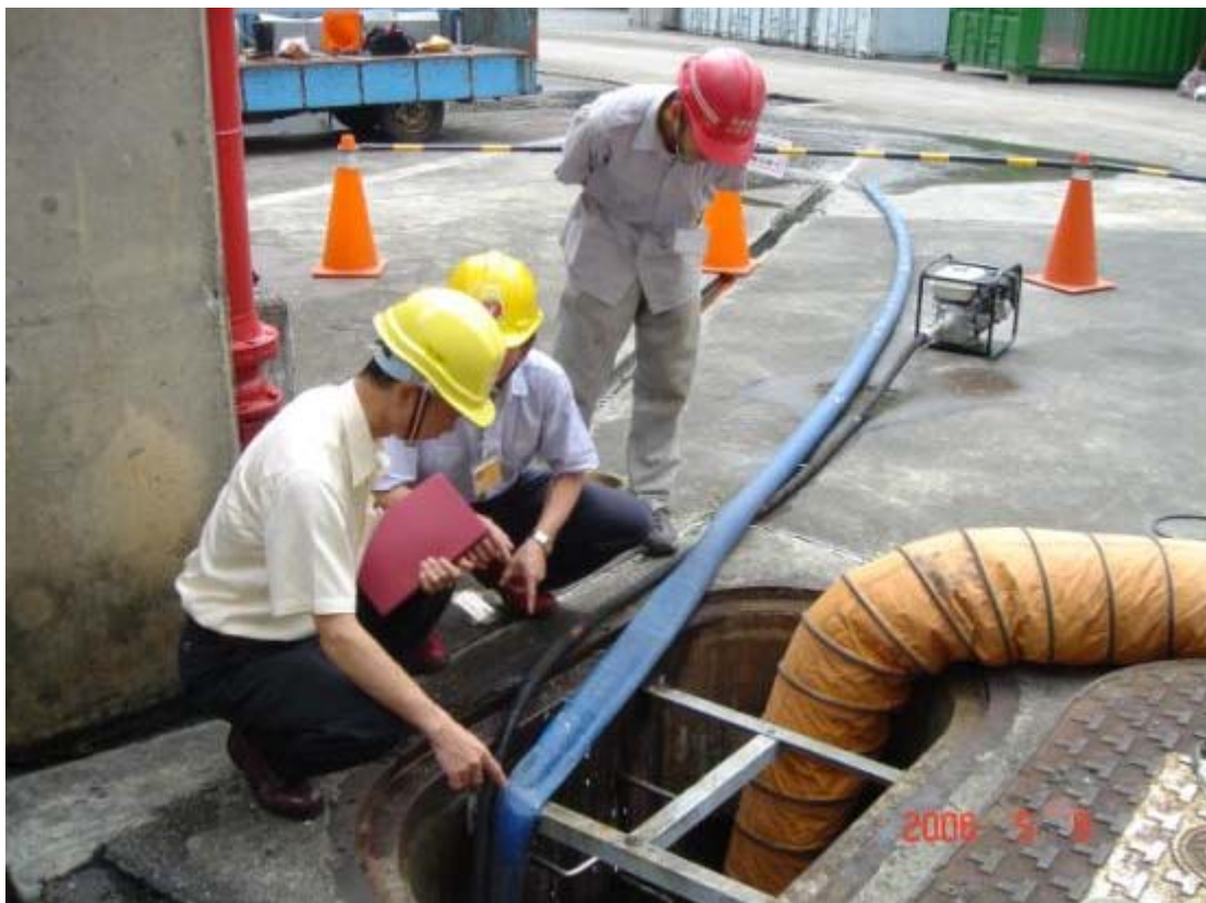
核一廠執程序書 757.5「廠內電纜溝預防護程序」 抽水現場查證實況
