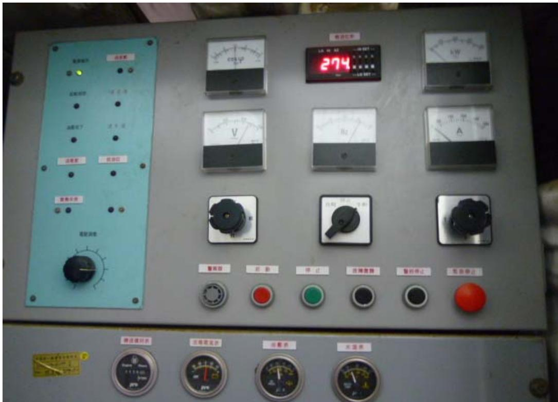
大樓抽水泵操作盤面(盤面儀表顯示抽水泵正運轉抽水中)
