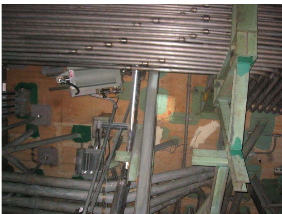
圖 4.新增振動加速規 2(115 度)
