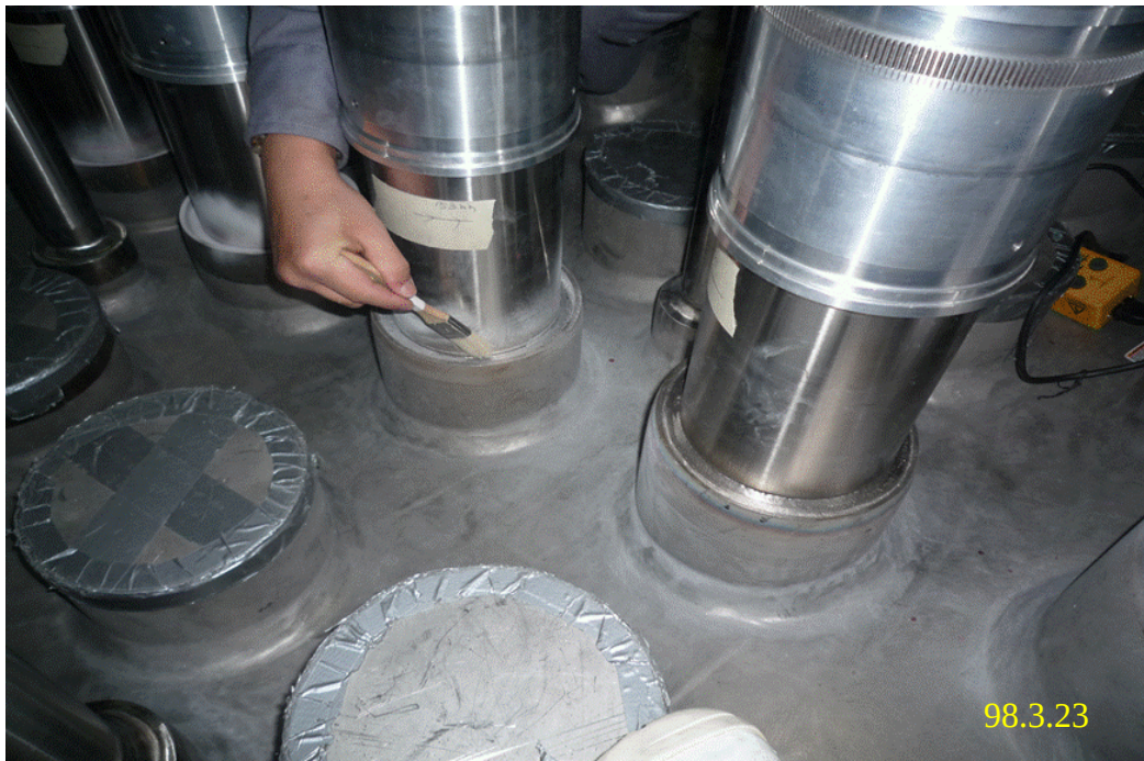
照片四：二號機反應器控制棒驅動殼安裝施工現況
