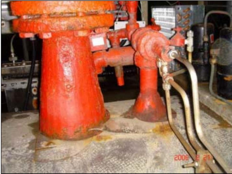
氣渦輪機廠房二氧化碳消防系統管路鏽蝕情形
