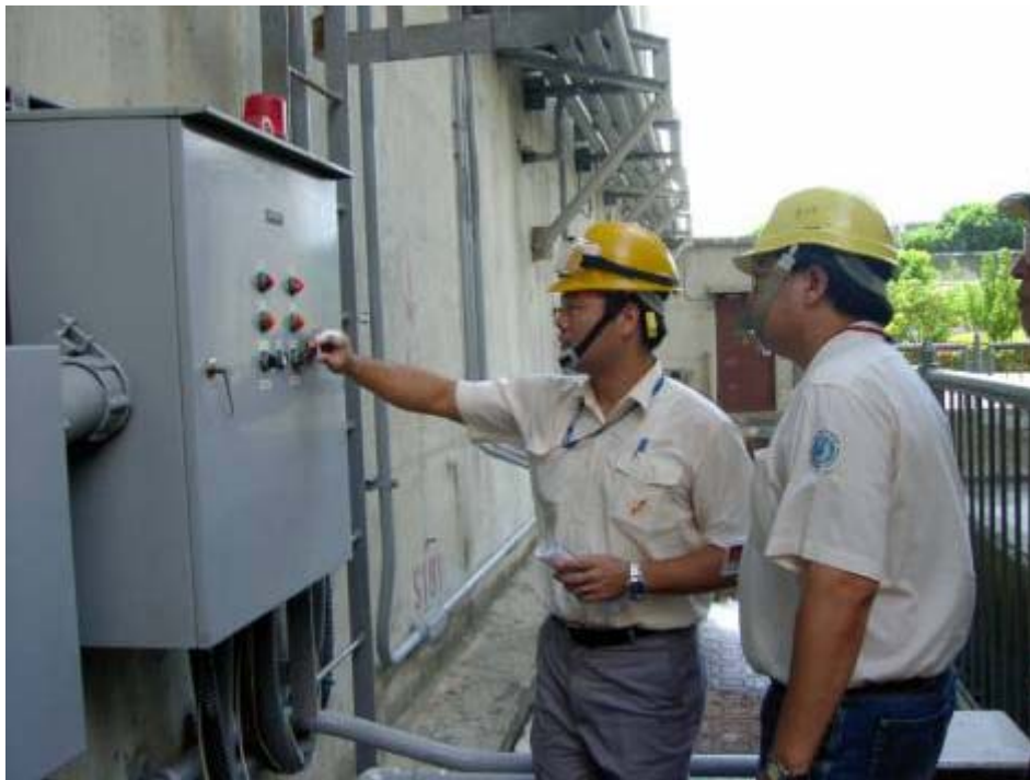
說明：視察員抽查排水坑沉水泵控制盤面情形。
