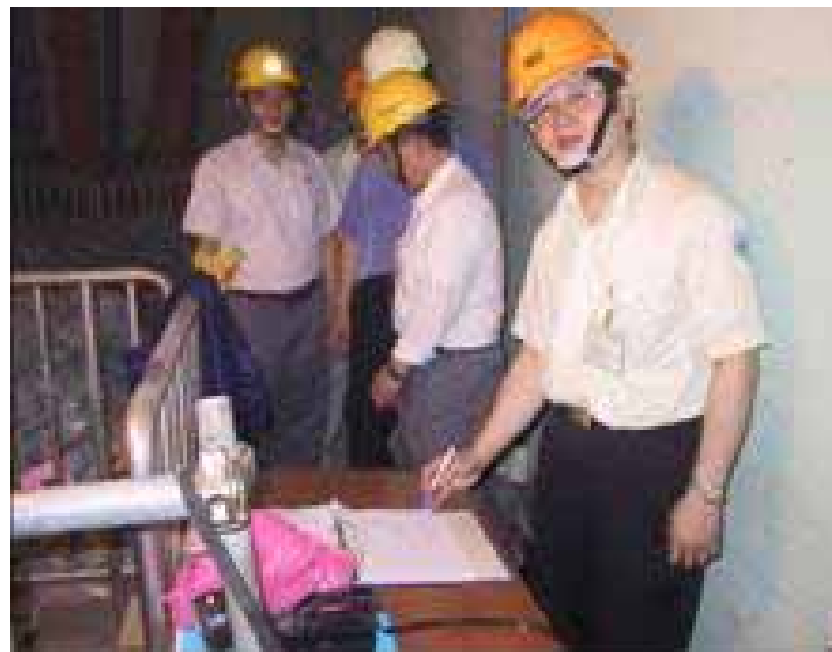
圖18：一號機控制室設備視察(六)
