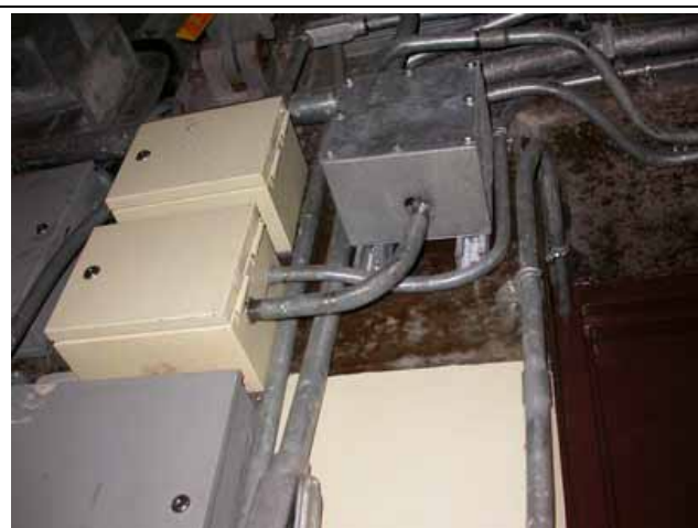
圖 17 電纜金屬連接頭脫
