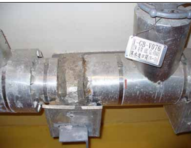
圖 12 保溫材缺鋁皮保護
