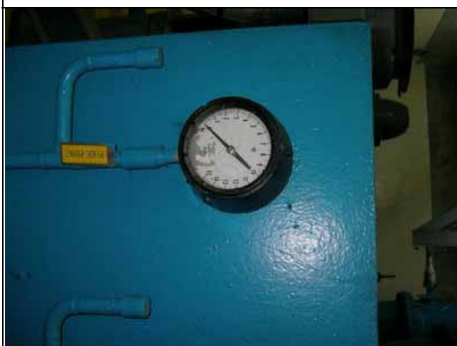
圖 5 壓力表缺固定螺絲
