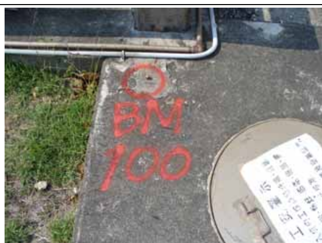
圖 1 核三廠緊急集水池之標高基準點
