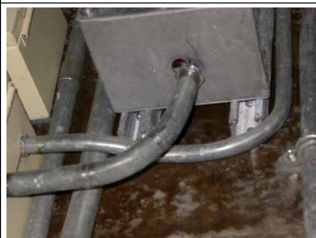
圖 18 電纜金屬連接頭脫
