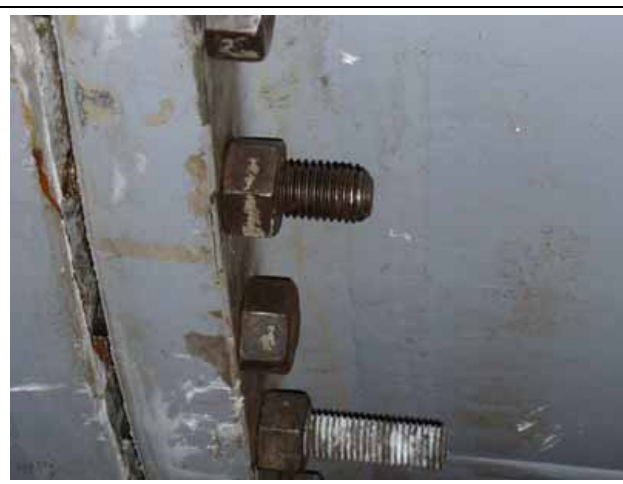
圖 10 端板螺栓螺牙未突出兩牙以上
