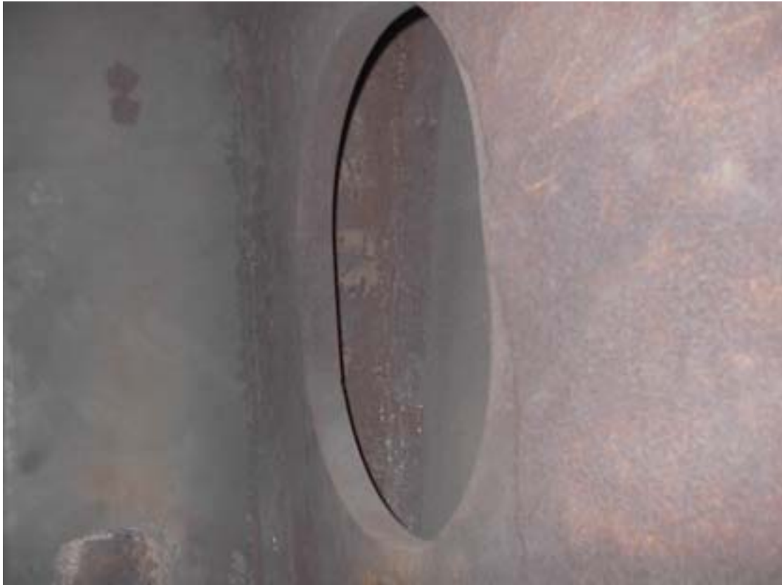
圖三：通道上下方小隔艙之側面開口情形
