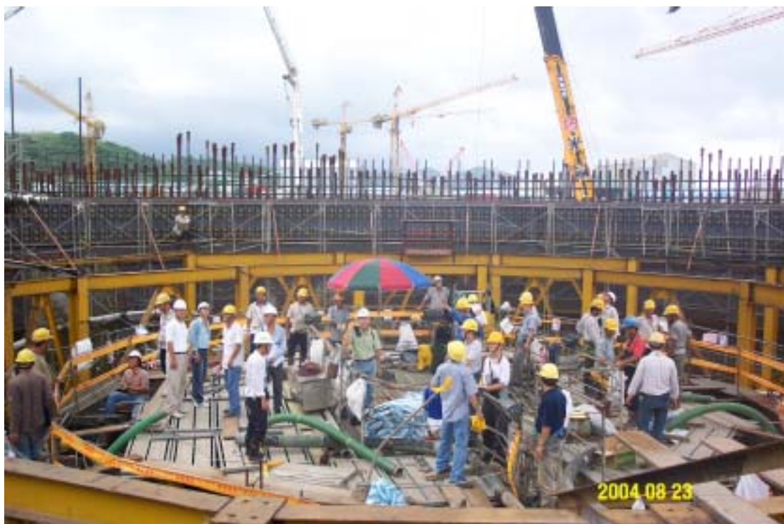
圖七：混凝土澆置前準備作業情形
