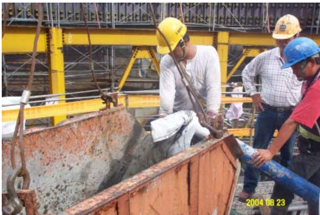
圖十一：潤管用水泥沙漿運棄情形
