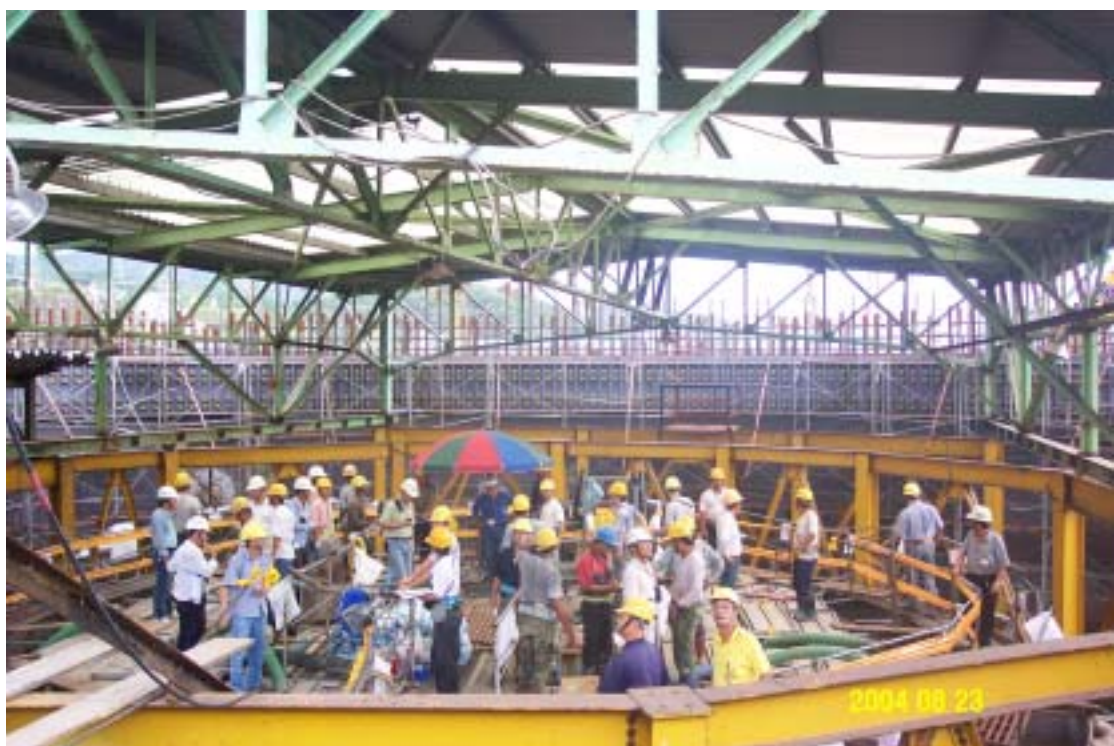
圖八：天候防護棚未拆除前現況
