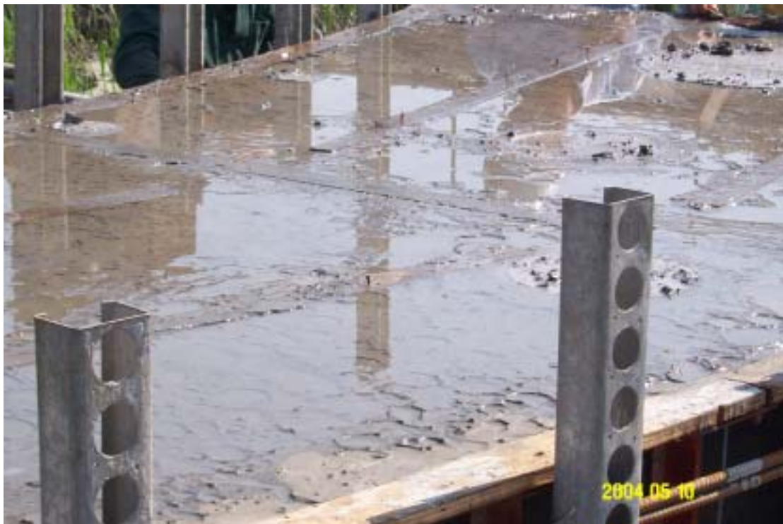
圖四：以木模組立進行混凝土澆置性試驗情形
