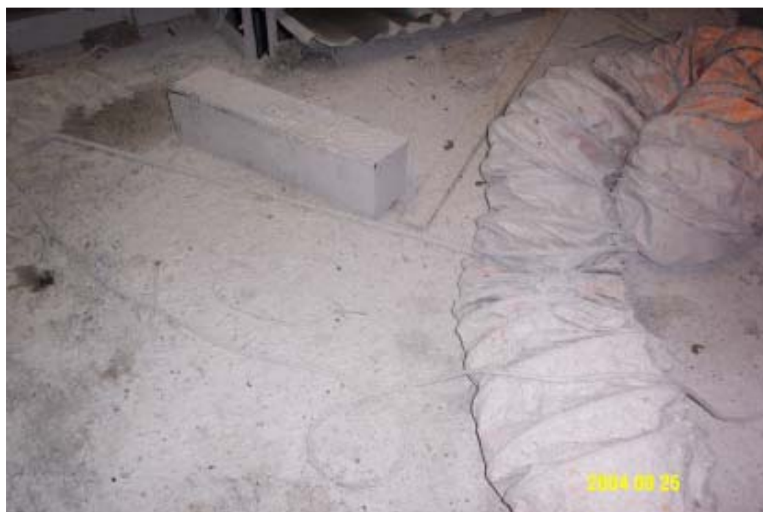
圖十四：下乾井工作平台覆蓋混凝土漿乾燥後情形
