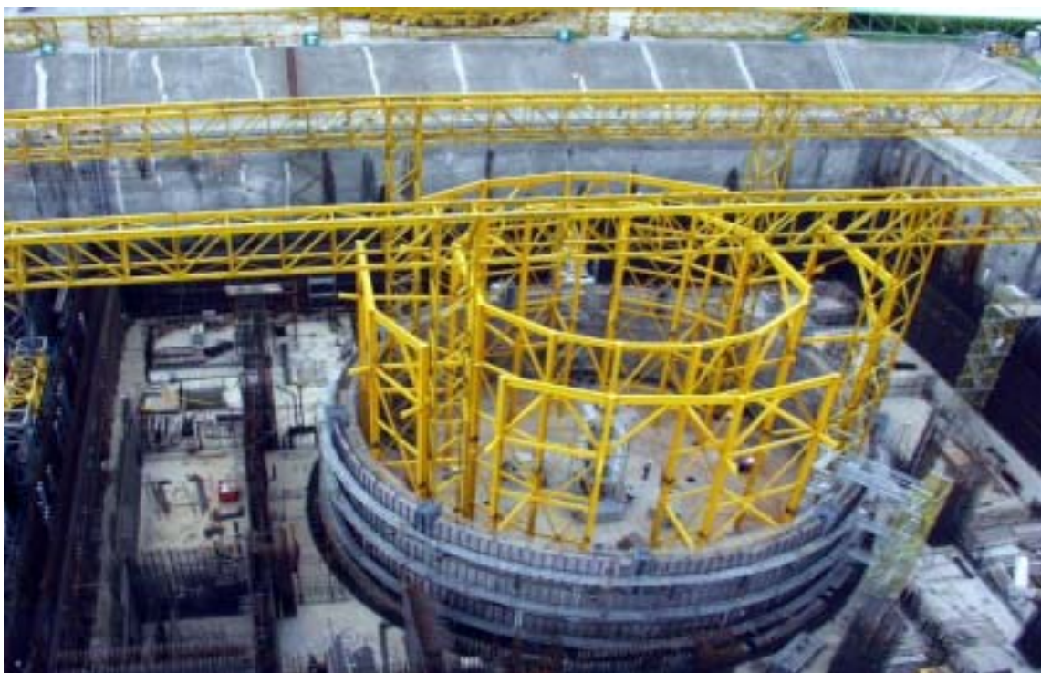
圖一：一號機反應器廠房現況
