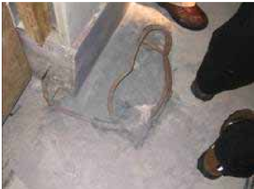
圖17：一號機控制室設備視察(五)
