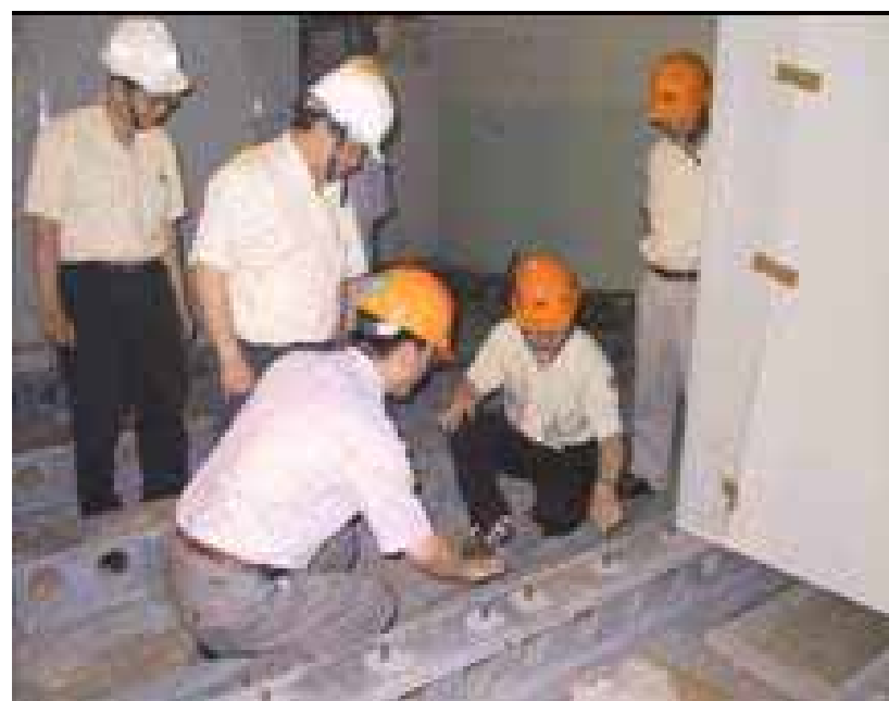
圖16：一號機控制室設備視察(四)
