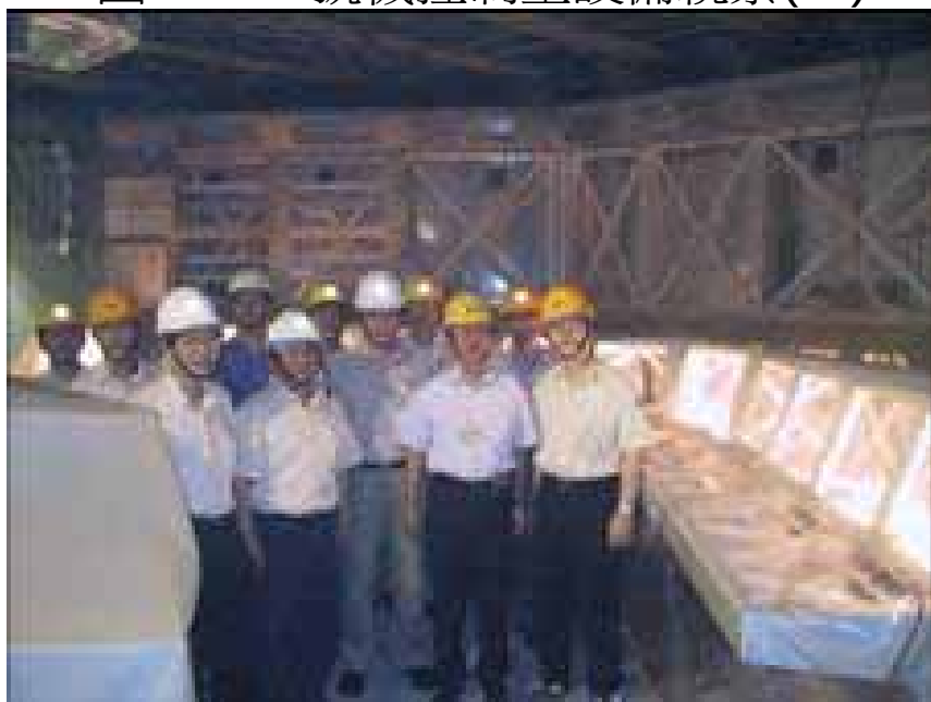
圖15：一號機控制室設備視察(三)
