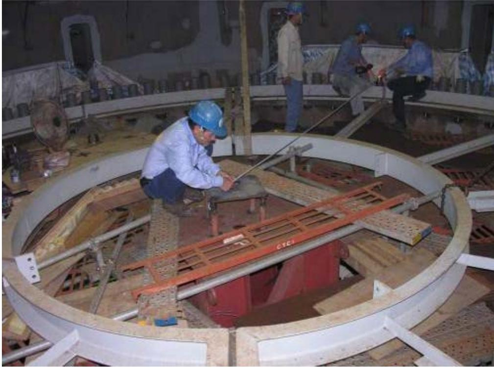
照片二十五、Support Skirt Flange 上反應器基礎螺栓安裝後量測情形(一)
