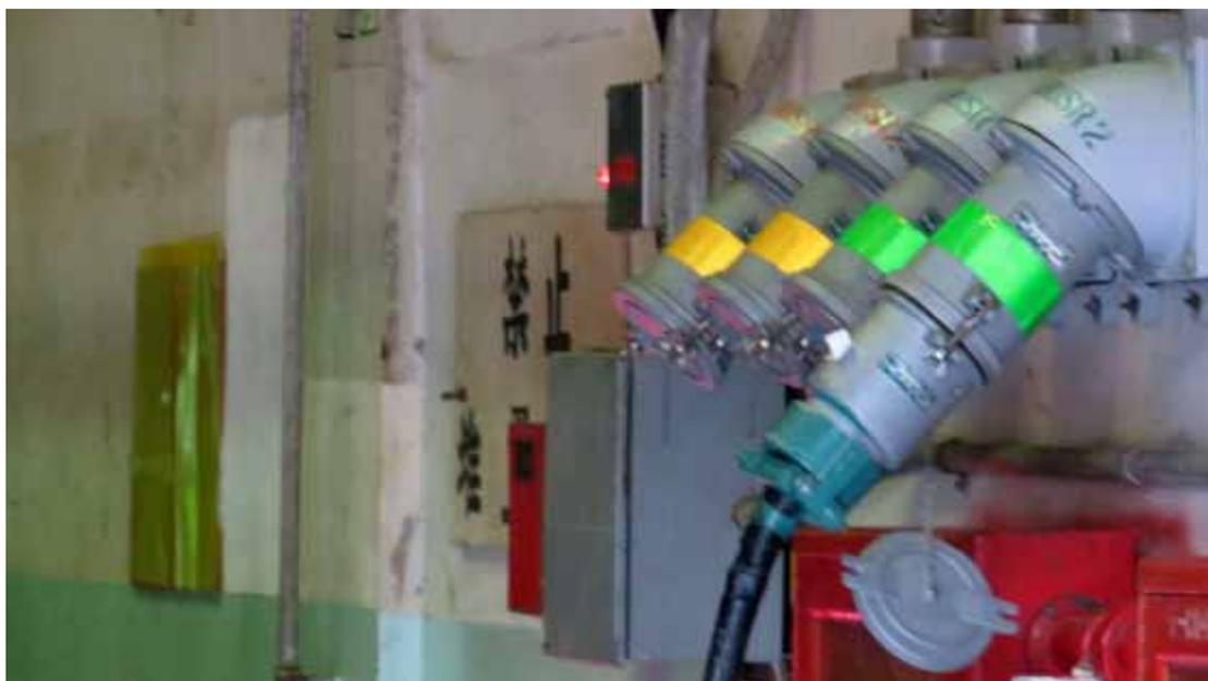
圖 4-1 移動式柴油發電機與匯流排的接頭
