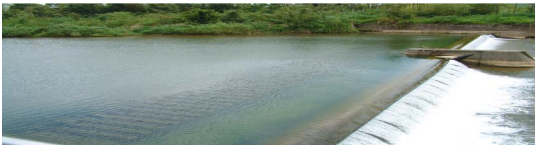
貢寮自來水廠水源壩
