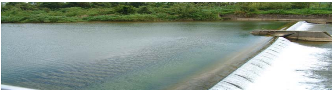
貢寮自來水廠水源壩
