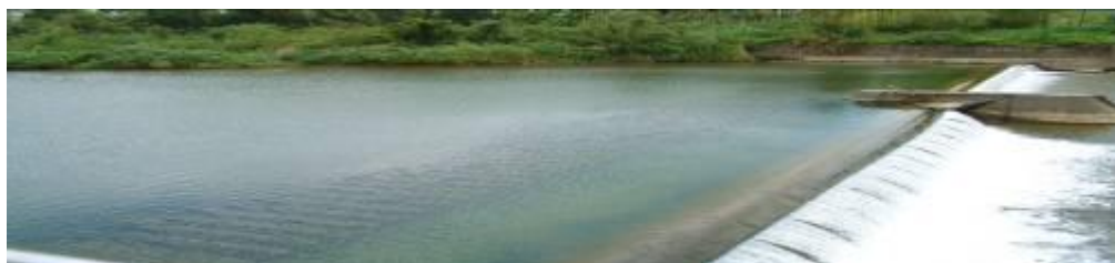
貢寮自來水廠水源壩
