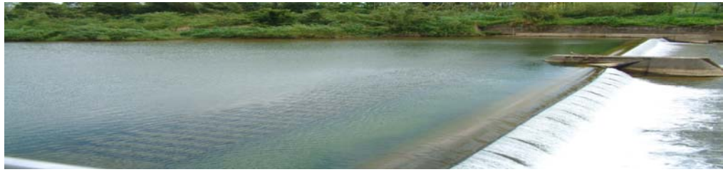
貢寮自來水廠水源壩
