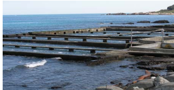
龍洞九孔養殖池
