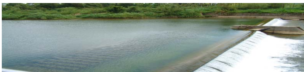
貢寮自來水廠水源壩
