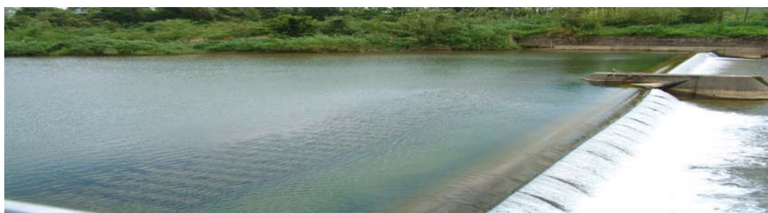
貢寮自來水廠水源壩
