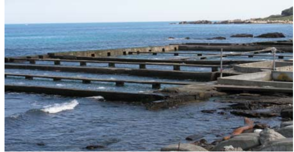
龍洞九孔養殖池
