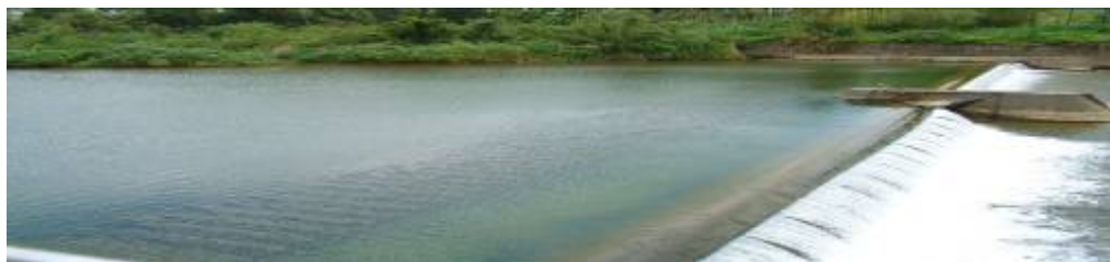
貢寮自來水廠水源壩
