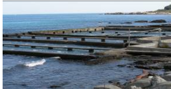
龍洞九孔養殖池
