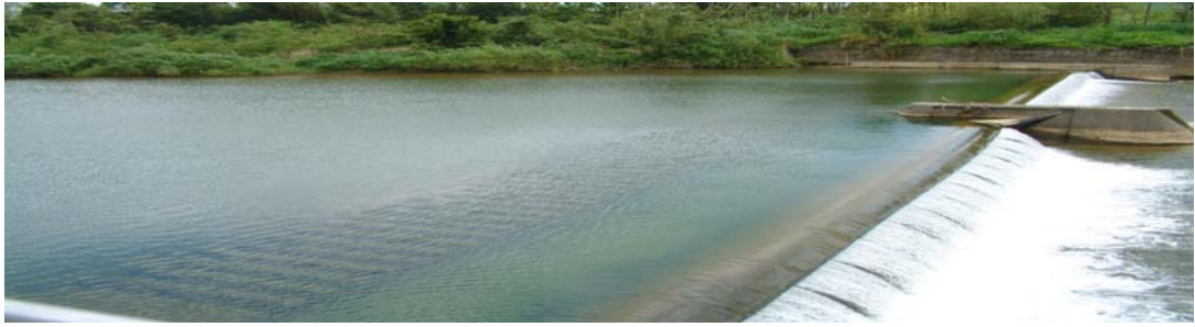
貢寮自來水廠水源壩
