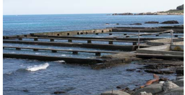
龍洞九孔養殖池
