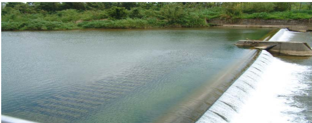
貢寮自來水廠水源壩
