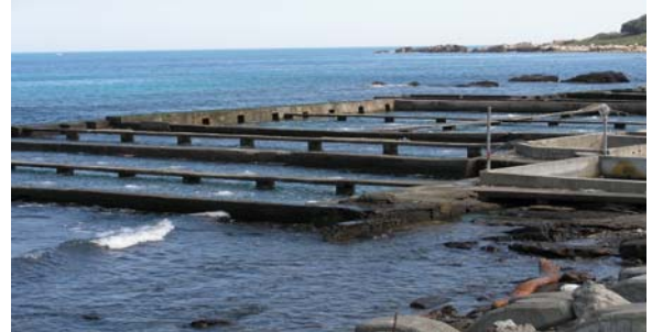
龍洞九孔養殖池
