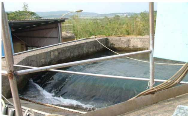
取樣點(自來水廠進水池)
