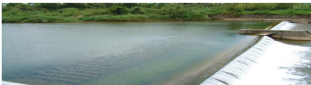
貢寮自來水廠水源壩
