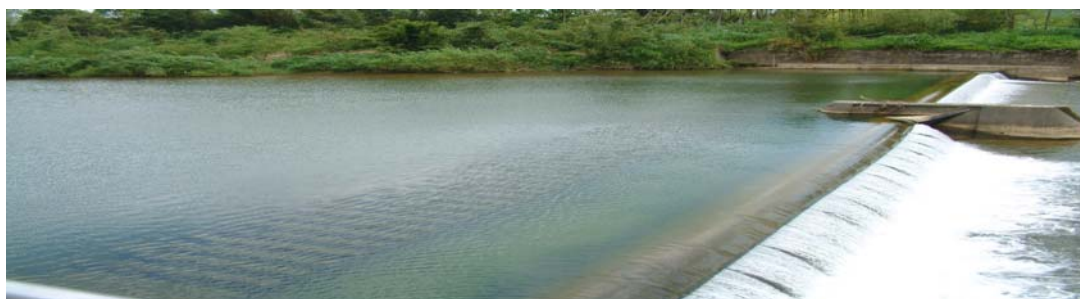
貢寮自來水廠水源壩
