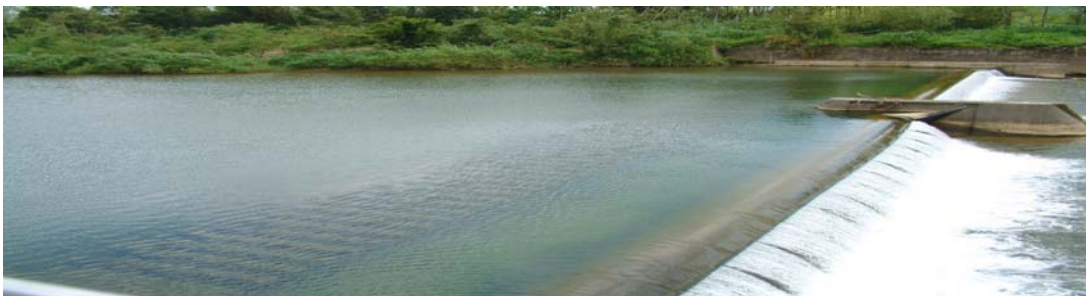
貢寮自來水廠水源壩
