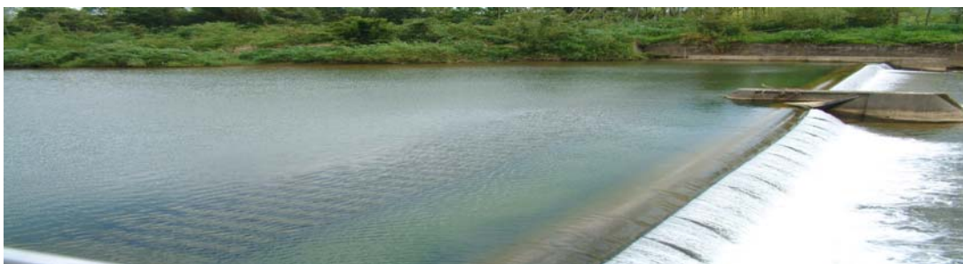
貢寮自來水廠水源壩
