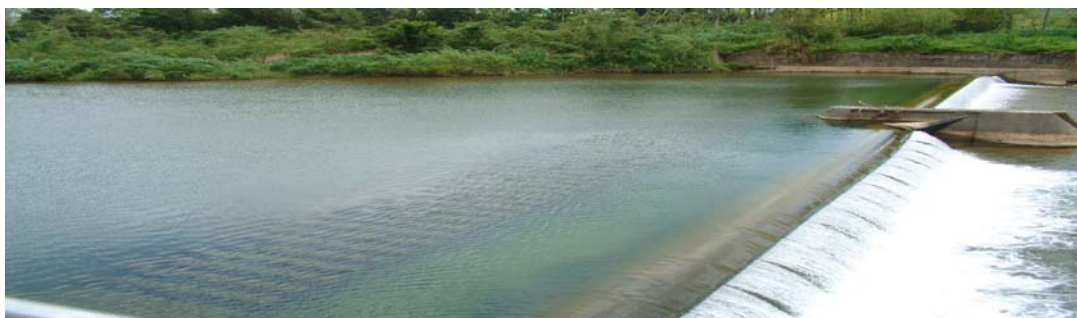
貢寮自來水廠水源壩
