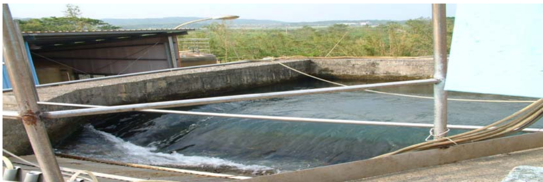
取樣點(自來水廠進水池)
