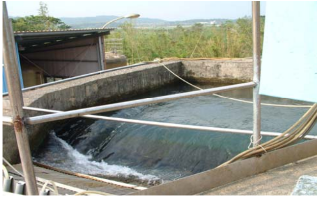
取樣點(自來水廠進水池)
