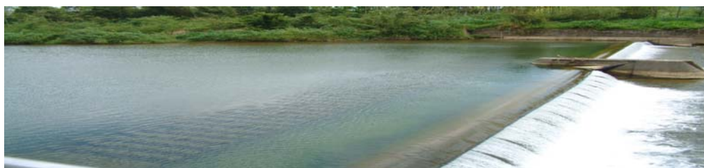
貢寮自來水廠水源壩
