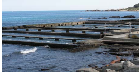
龍洞九孔養殖池
