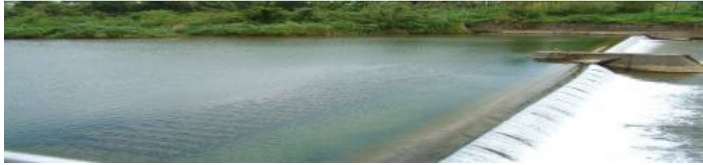
貢寮自來水廠水源壩
