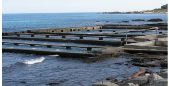
龍洞九孔養殖池
