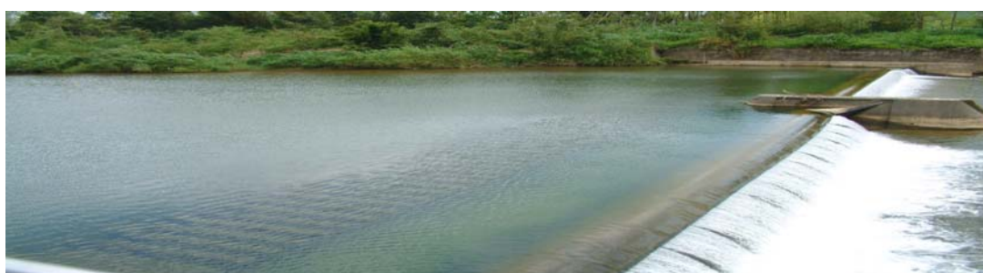
貢寮自來水廠水源壩
