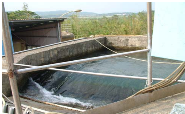
取樣點(自來水廠進水池)
