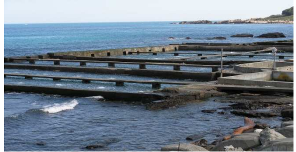
龍洞九孔養殖池
